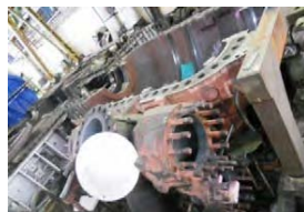
Obr. 6 Pohled na rozebrané soustrojí
