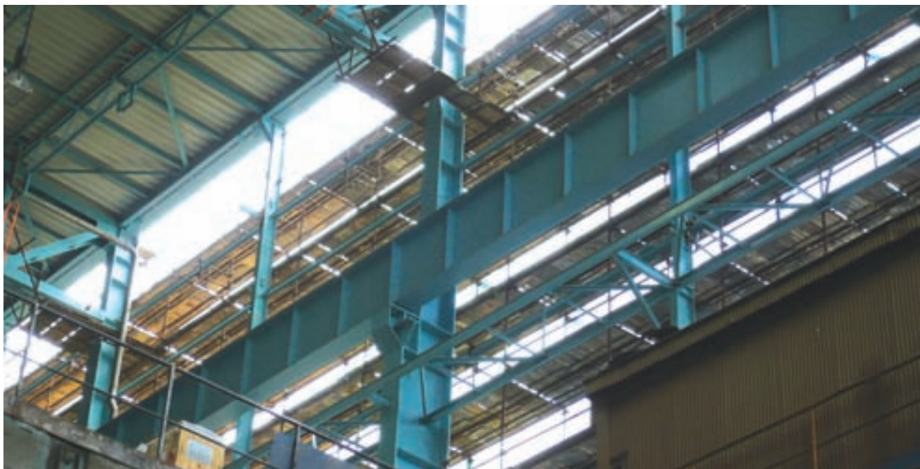
Repase a obnova nátěrů ocelových konstrukcí HVB
