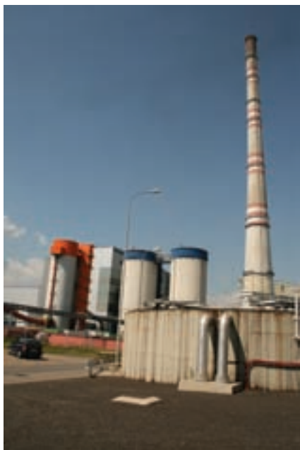
Pohled na strusková síla a část HVB
