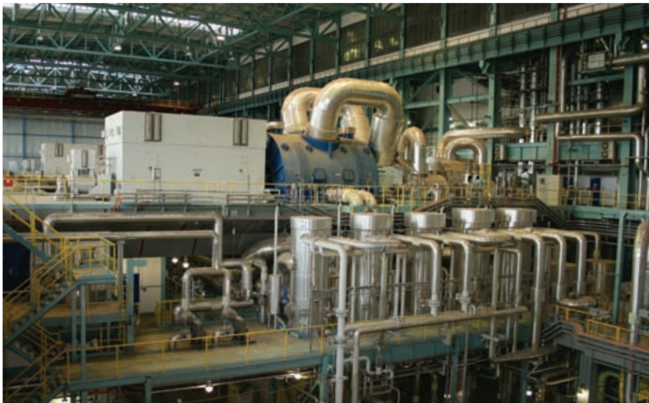
Pohled na hotovou turbostolici s usazenou turbínou
