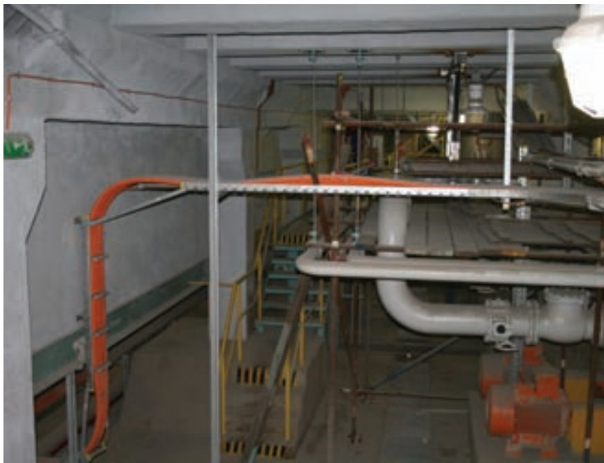
Provádění sanací v prostorách HVB
