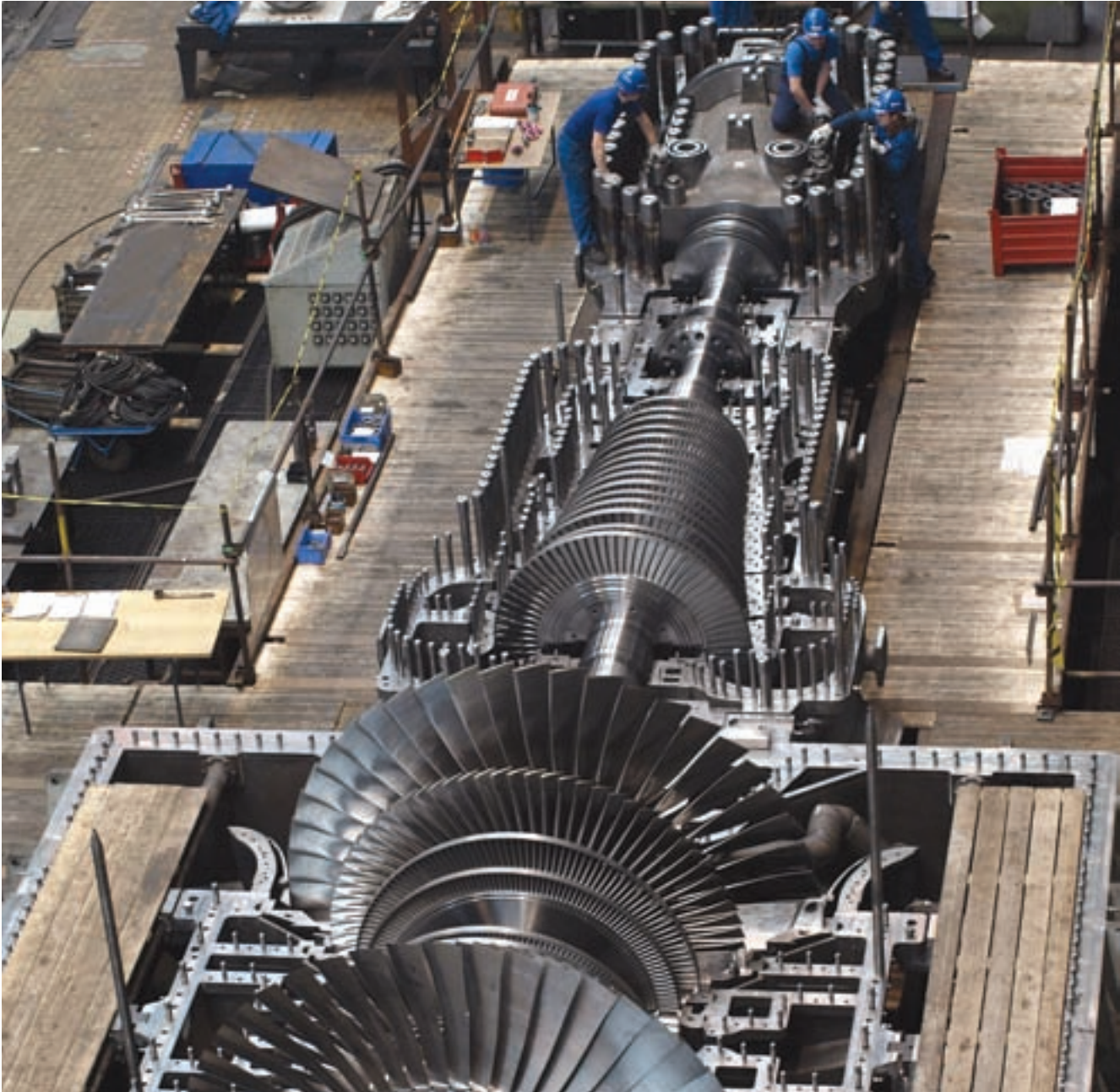
Kontrolní montáž turbíny 200 MW pro blok 21 ve ŠKODA POWER
