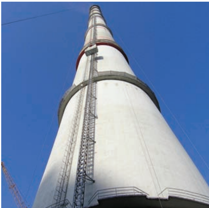
Pro potřeby demolice 300metrového komínu tušimické dvojky bude využitý i 250metrů dlouhý výtah, který je svou délkou českým unikátem
