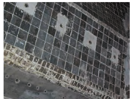
Hotové vyzdívky přední stěny
