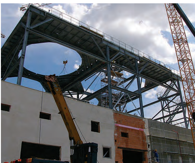
Montáž ocelových konstrukcí aerokondenzátoru
