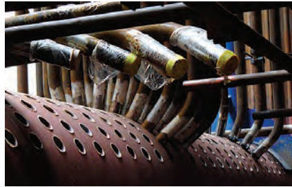
Detail montáže kotlového svazku
