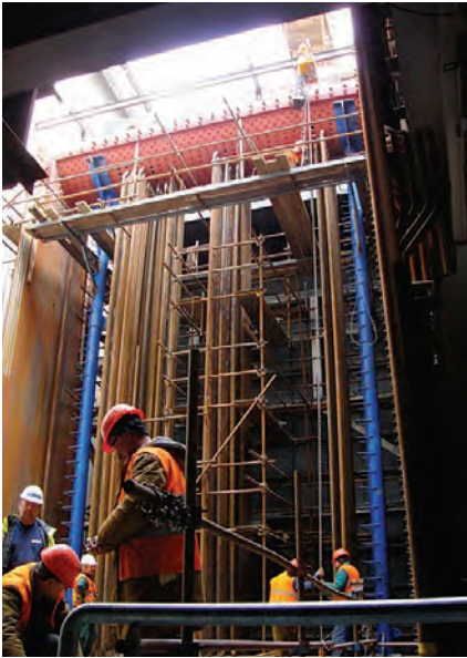
Montáž kotlového svazku
