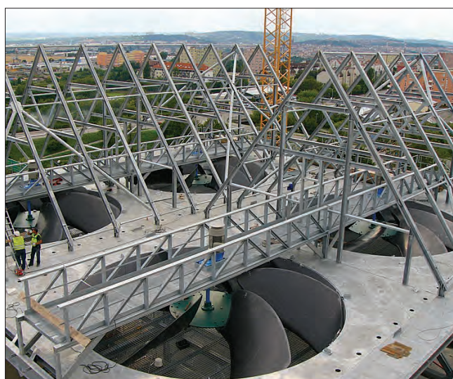
Montáž ocelových konstrukcí aerokondenzátoru
