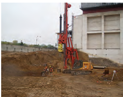
Výstavba turbínové haly
