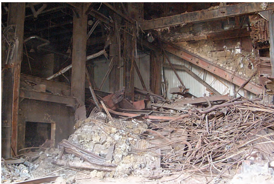
Demolice v kotelně
