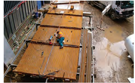
Předmontáž membránových stěn
