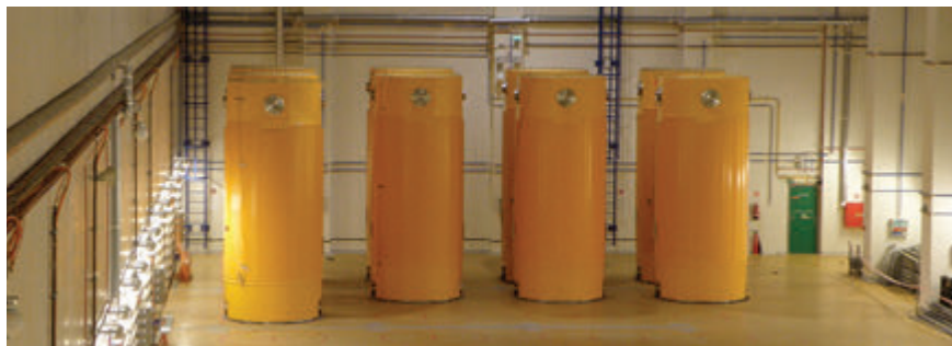
Obalové soubory Castor® 1000/19 ve skladu vyhořelého paliva
