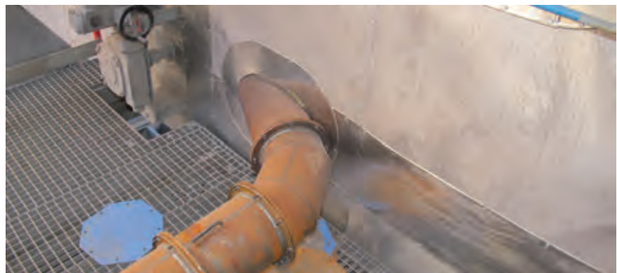
Připojení testovacího zařízení na stávající kouřovod
