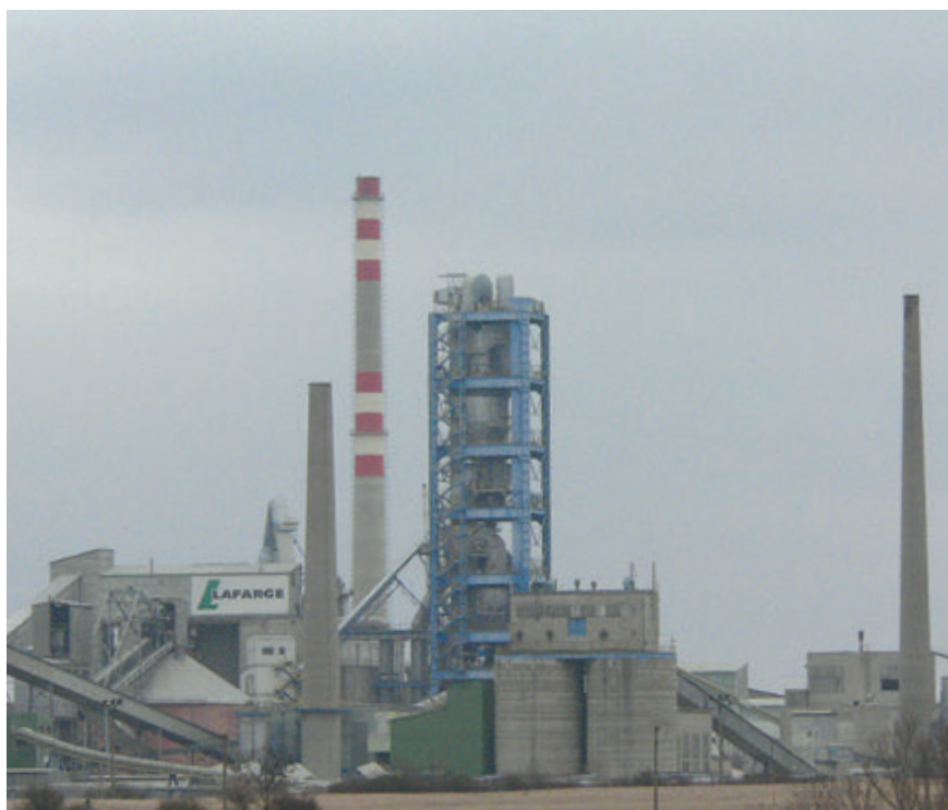
Obr. 1 – Pohled na konstrukci výměníku
