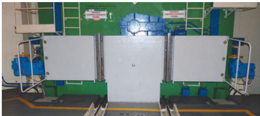
Nová konstrukce mostu transportní propusti 1HUGA101V
