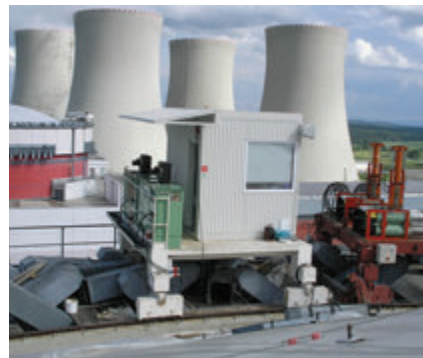
Zařízení na střeše HVB používané pro kontroly předpětí
