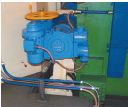
Rekonstruovaný elektropohon mechanismu hermetizace HUGA101V
