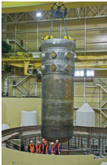
Obr. 10 – TNR pred osadením do šachty reaktora 4. bloku
