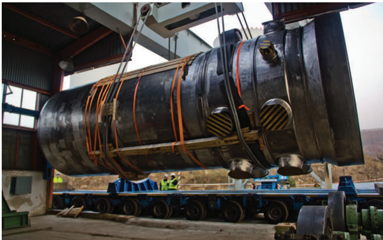
Obr. 1 – Manipulácia s TNR pomocou jednoúčelového zariadenia PU 250 počas nakladania na prepravný náves
