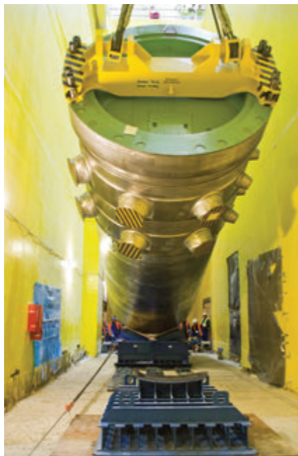
Obr. 9 – Vztýčovanie TNR pomocou prípravkov a traverzy
