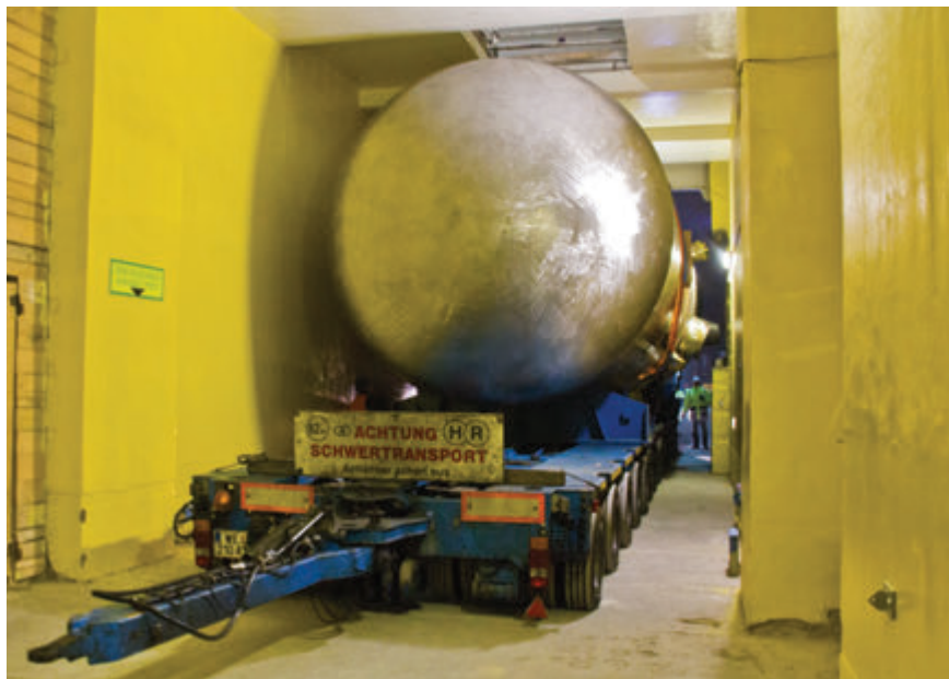
Obr. 5 – Najobťažnejšia fáza - transport cez bránu do koridoru hlavného výrobného bloku
