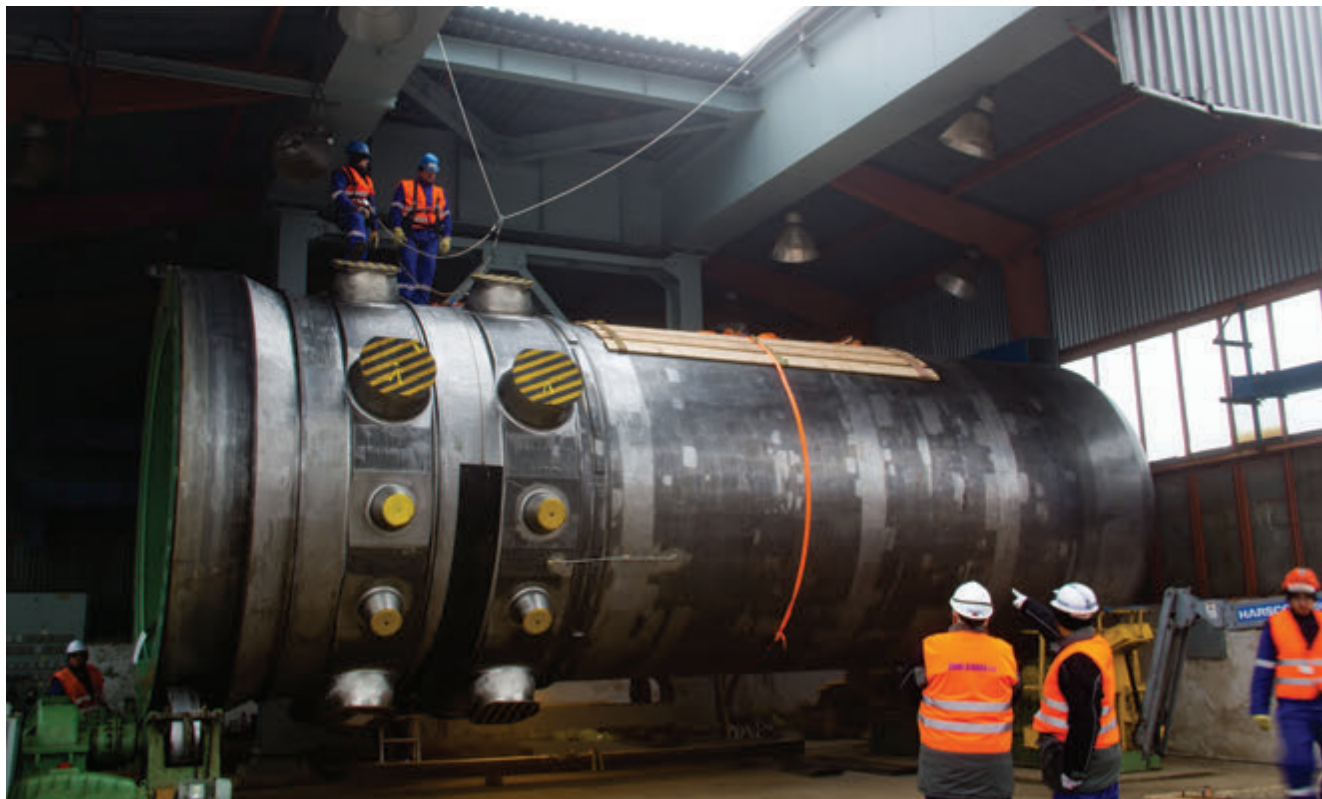
Obr. 3 – Prekladací uzol - TNR na polohovacom zariadení počas prípravných prác pred transportom
