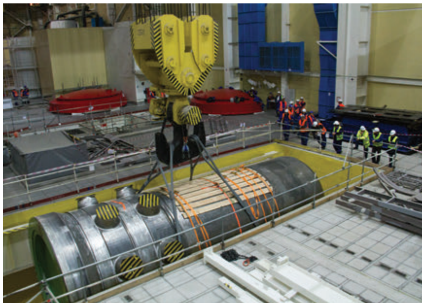
Obr. 6 – Premiestnenie TNR z koridoru na reaktorovú sálu pomocou mikrozdvíhu 250 t zdvíhacieho zariadenia
