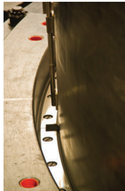
Obr. 11 – Záverečná fáza - pri osadení TNR bol vykonaný kontrolný otláčok
