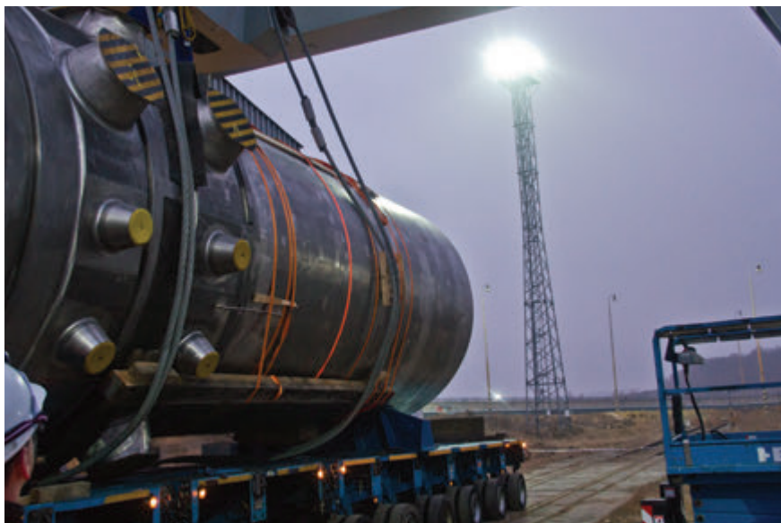
Obr. 2 – Uloženie TNR na 14osový náves
