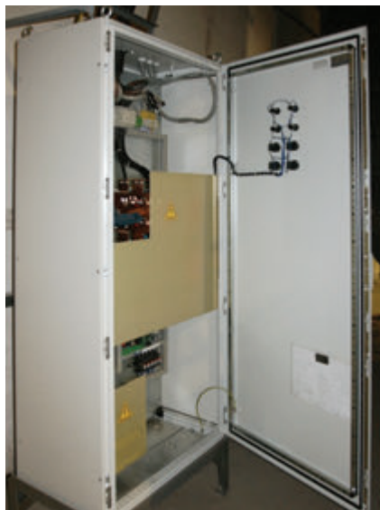
Hala primárních a sekundárních ventilátorů všech čtyř kotlů ZEVO Praha
