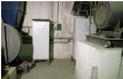
Pohled na frekvenční měniče v krytí IP55 v místě primárních a sekundárních ventilátorů
