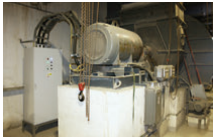
Pohled na frekvenční měniče v krytí IP55 v místě primárních a sekundárních ventilátorů
