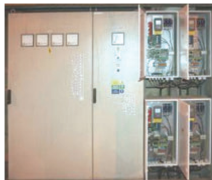
Napájecí rozváděč + měniče frekvence detail řetězu po úpravě
