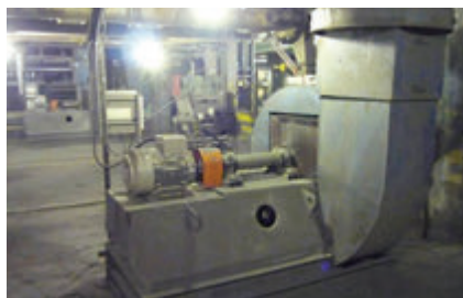
Primární a sekundární ventilátory na Teplárně Trmice
