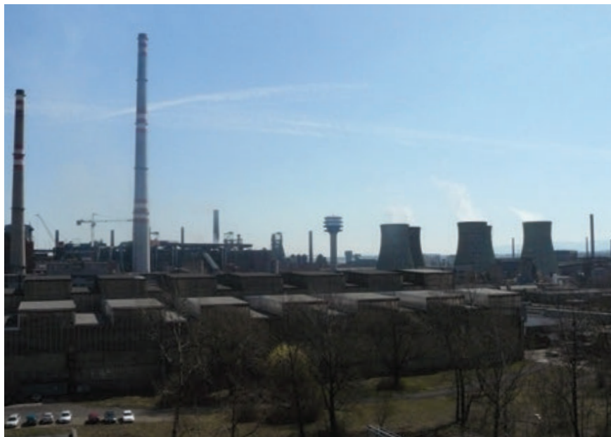
Celkový pohled na ArcelorMittal Energy Ostrava
