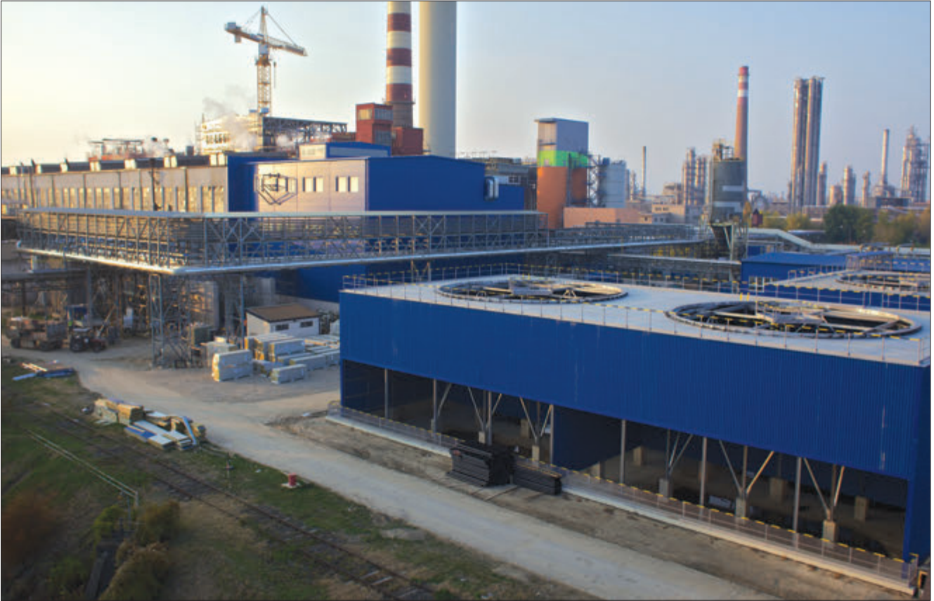
Nové cirkulačné centrum chladiacej vody
