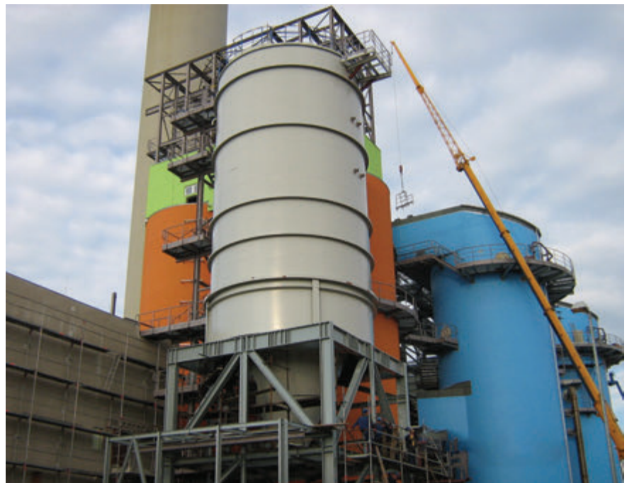
Výstavba odsírovacej jednotky spalín, jún 2011
