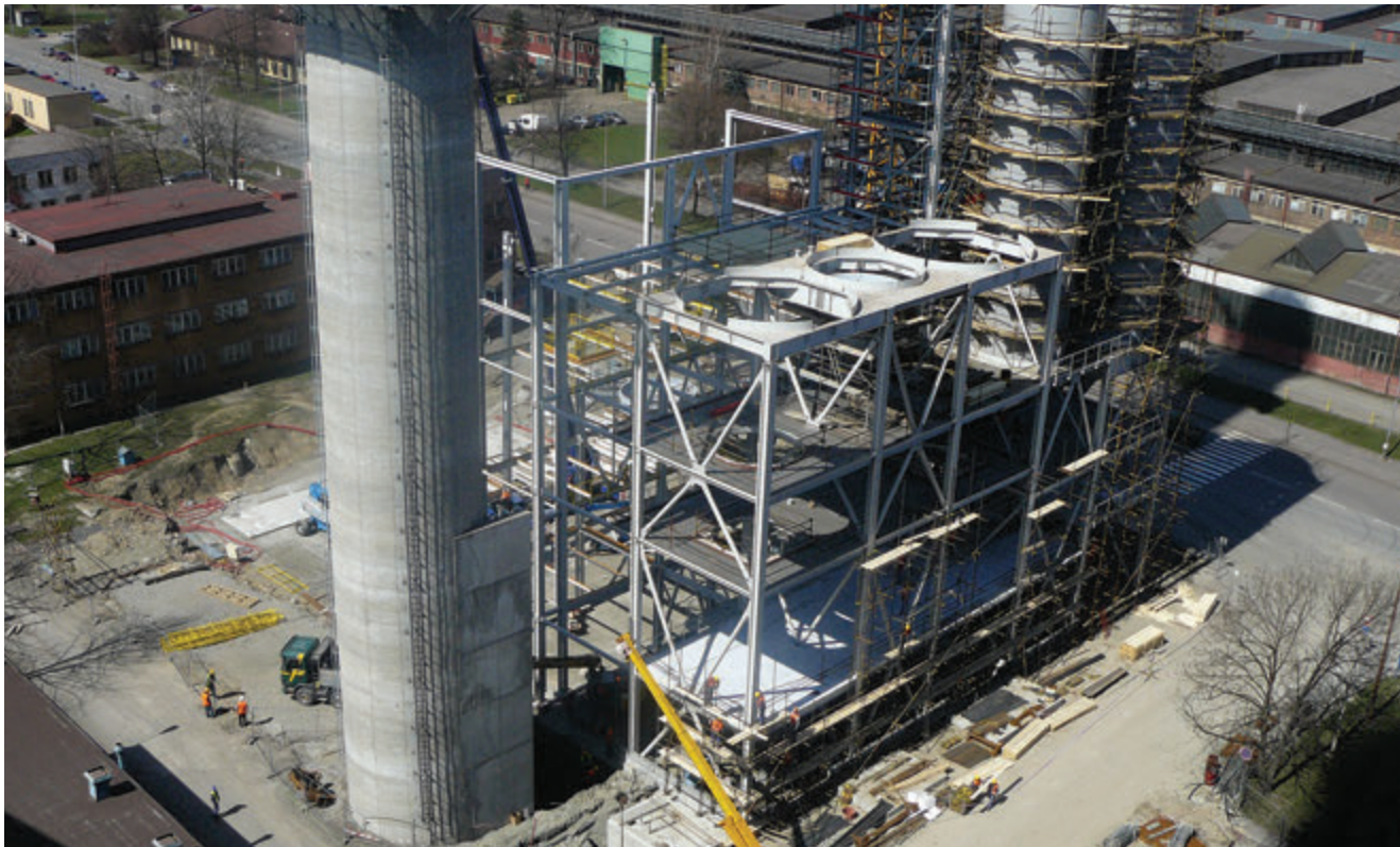
Celkový pohled na staveniště odsíření ArcelorMittal Energy Ostrava
