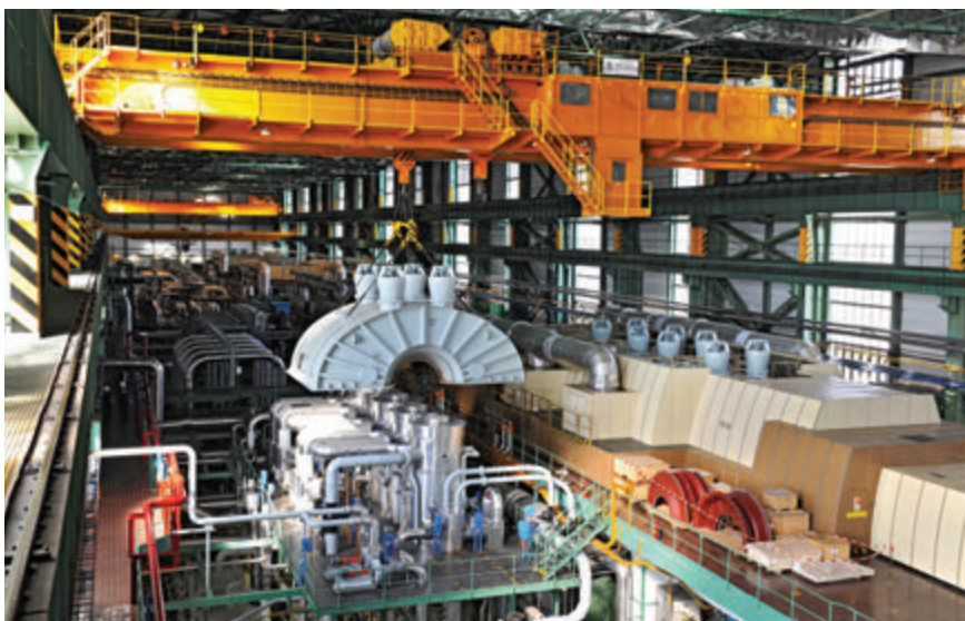
Montážní práce v elektrárně
