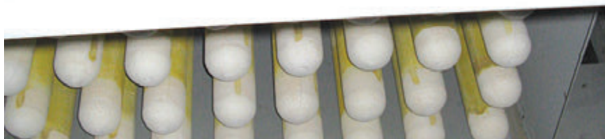
Obr. 4 - Instalace filtračních elementů do 4D filtru ve spalovně nebezpečných odpadů
