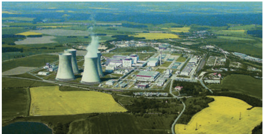
Letecký pohled na jadernou elektrárnu Temelín
