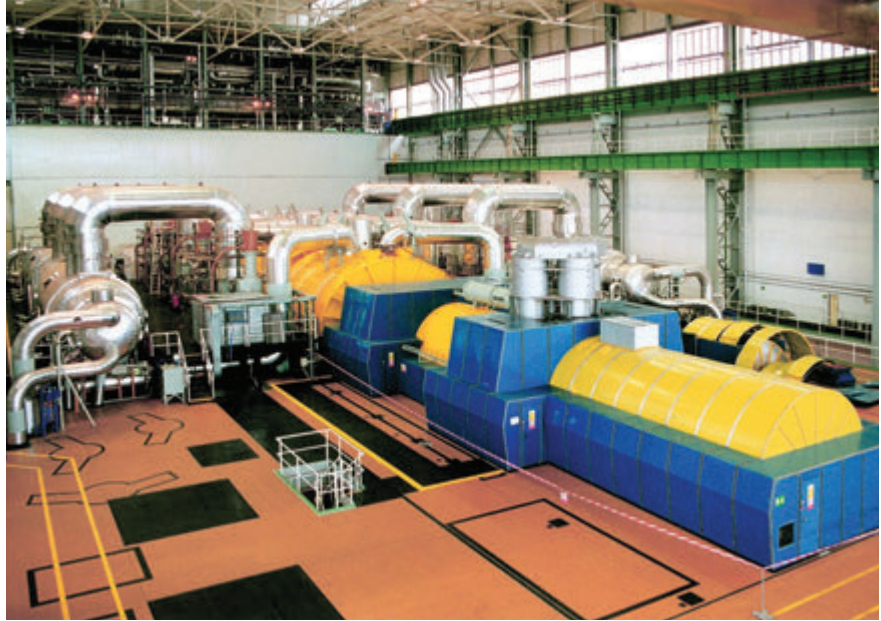
Pohled do strojovny - místo realizace jednoho logického celku
