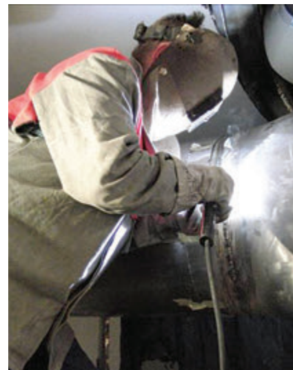
Snímek ze svařování na hlavním cirkulačním potrubí
