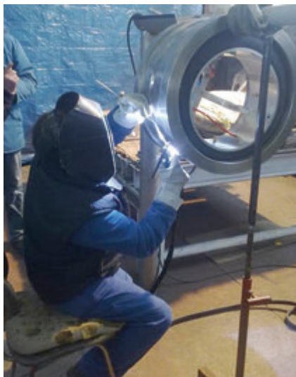
Svařování „ostrého“ kontrolního spoje na DN 500 (production test)
