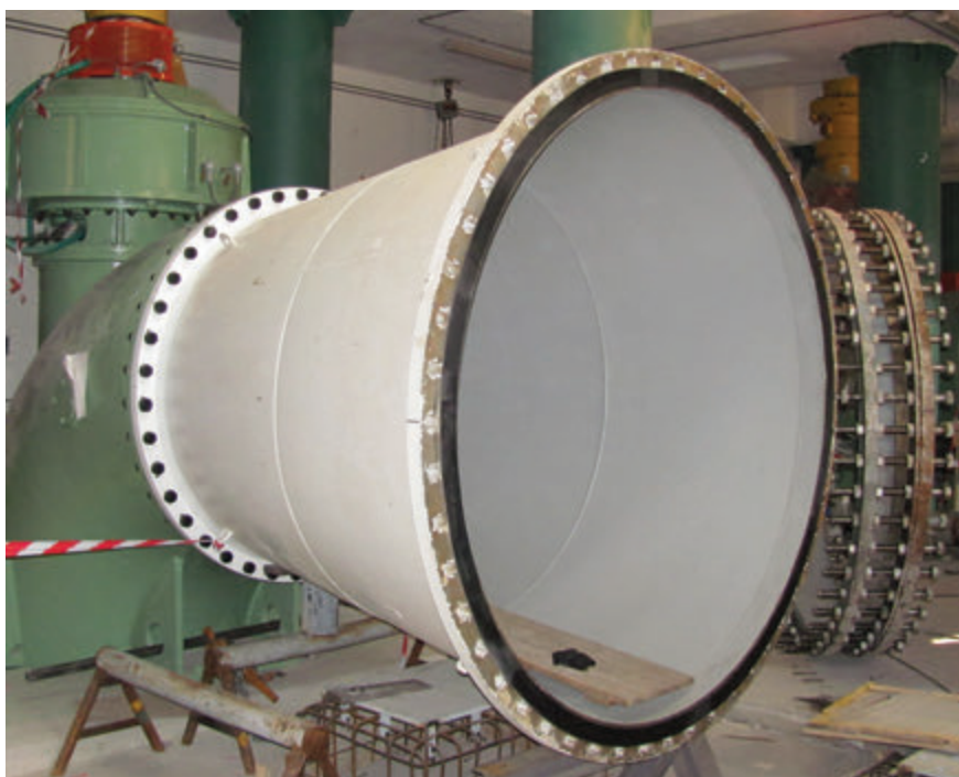
Výtlač a přechodový díl chladícího čerpadla SIGMA 1600-BQDV, čerpací stanice chladící vody M034
