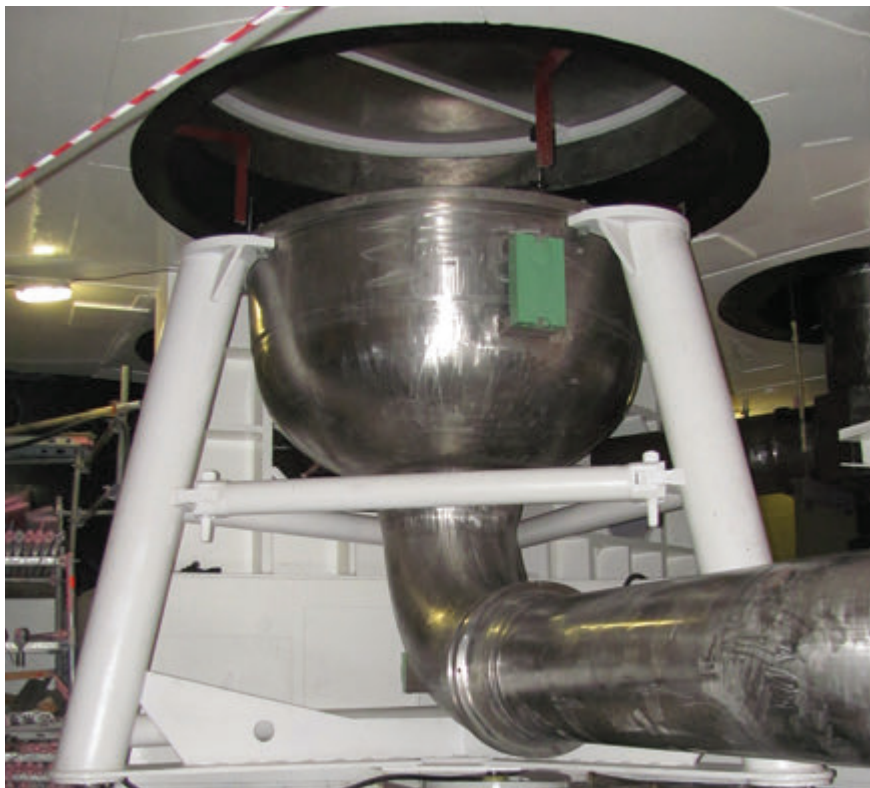
Základový rám a sání hlavních cirkulačních čerpadel GCN-317, primární okruh M034
