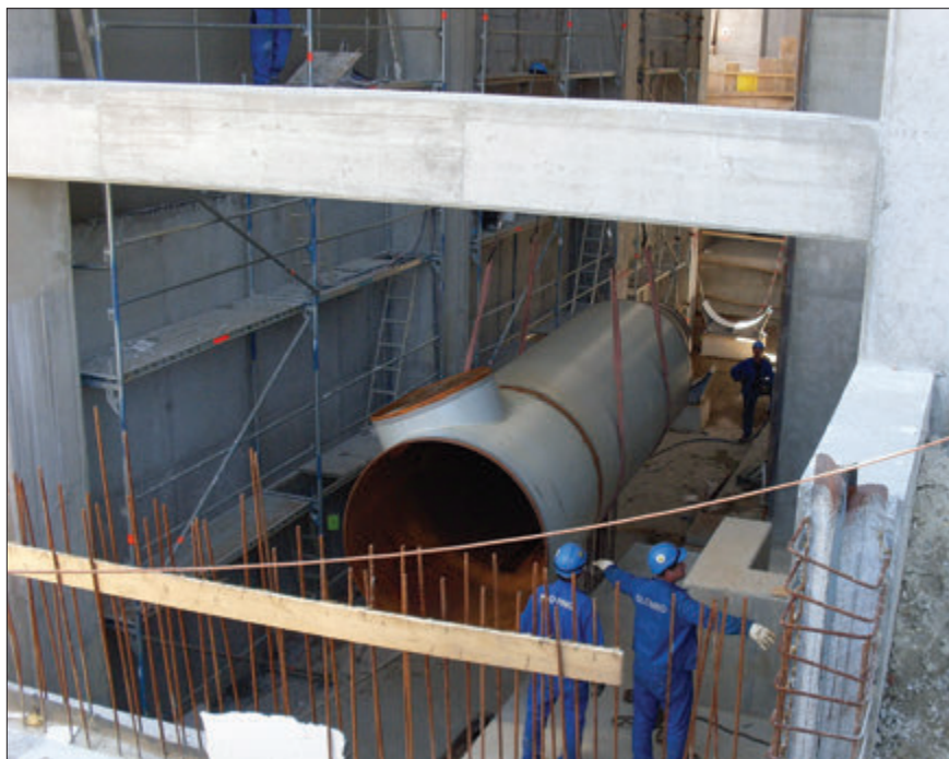
PC4 – montáž potrubných rozvodov chladiacej vody
