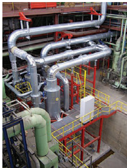
Montáž potrubných rozvodov komplikuje aj fakt, že realizácia diela prebieha za neprerušenej prevádzky a najmä bezprostredne v priestoroch jestvujúcej strojovne - ilustračné foto
