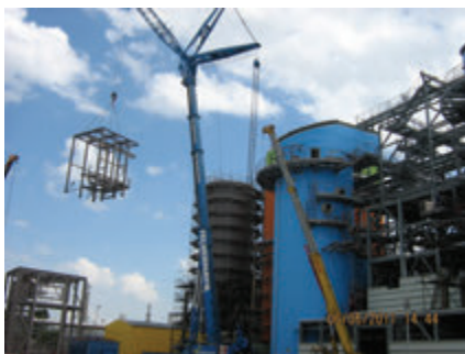
Montážne práce na odsírovacej jednotke
