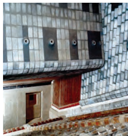
Trysky sekundárního vzduchu v zadní stěně ohniště
