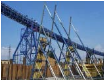
Stavba šikmých sloupů
