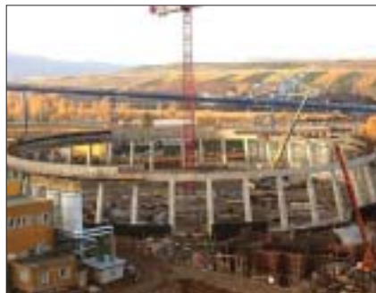
Dokončené návodní křídlo
