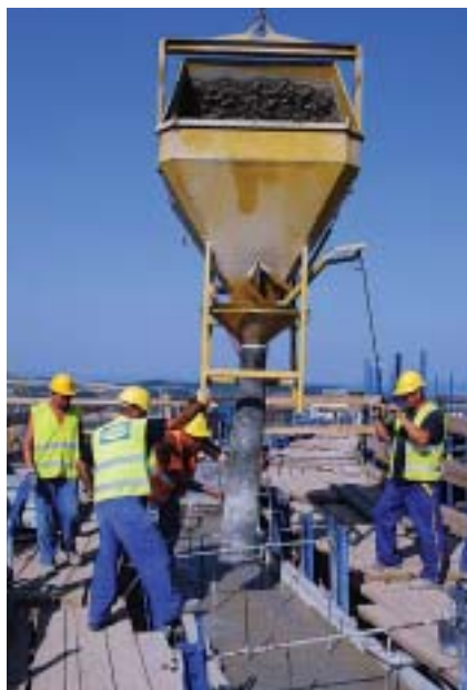
Betonáž posledního pásku
