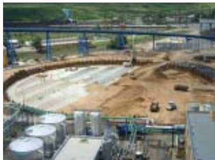
Betonáž pilotovací roviny
