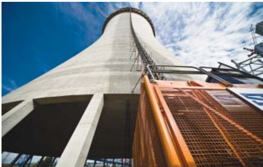
Stavební výtah na věž
