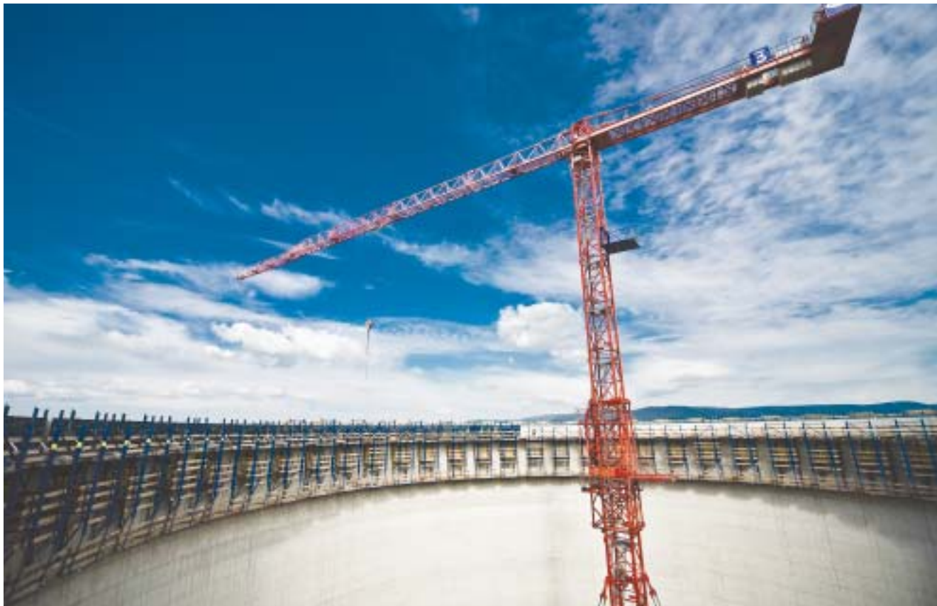
Pohled na bednění a výškový jeřáb
