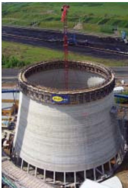
Tažení pláště věže
