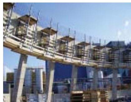
Montáž soupravy pro tažení pláště
