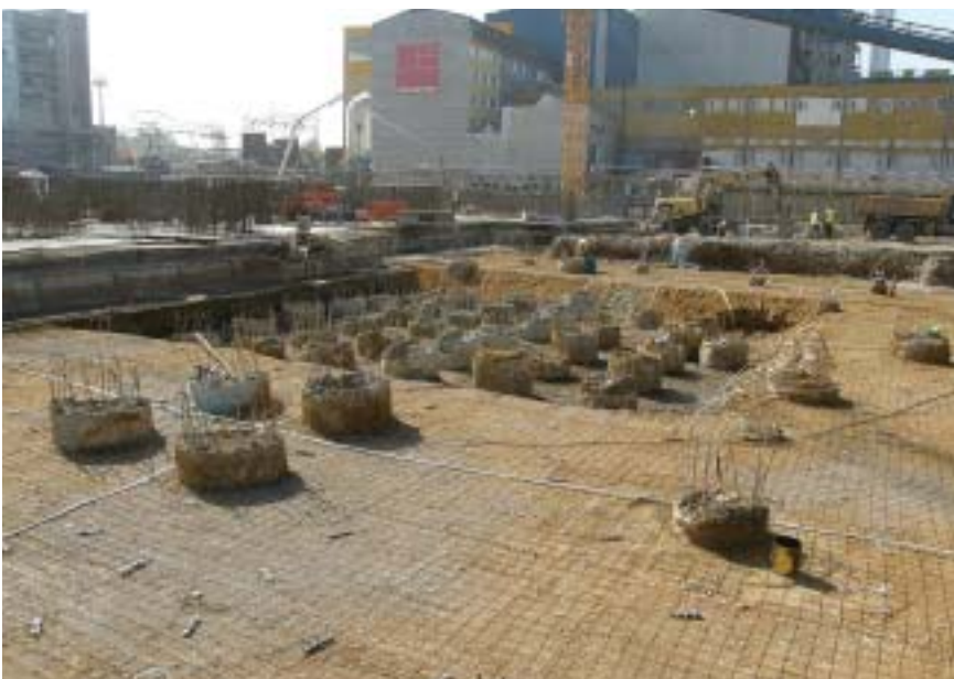
Část pilotových základů kotelny
