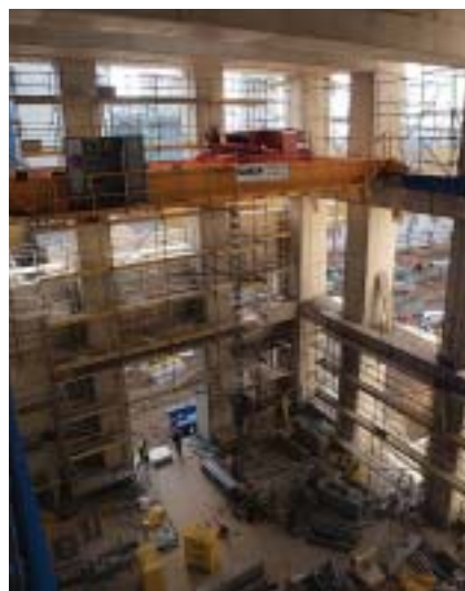
Dokončený betonový skelet mezistrojovny
