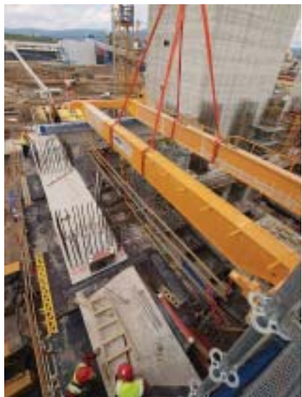
Osazování mostového jeřábu mezistrojovny
