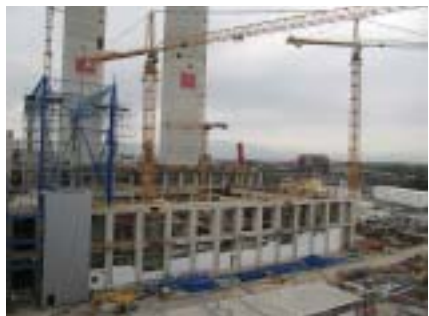
Montáž ocelové konstrukce strojovny v předstihu před betonovými konstrukcemi
