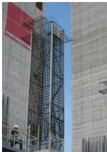
Armokoš budoucího betonového sloupu - provizorní podpora ocelového zastřešení strojovny
