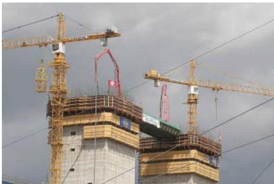
Šplhací bednění, obslužné jeřáby a výložníky čerpadel betonu
