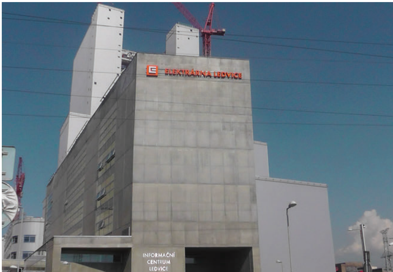
Informační centrum, za ním nový zdroj v Ledvicích
