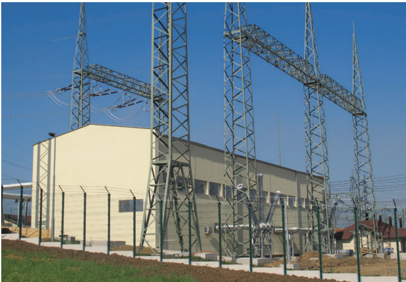
Budova se zapouzdřenou rozvodnou
