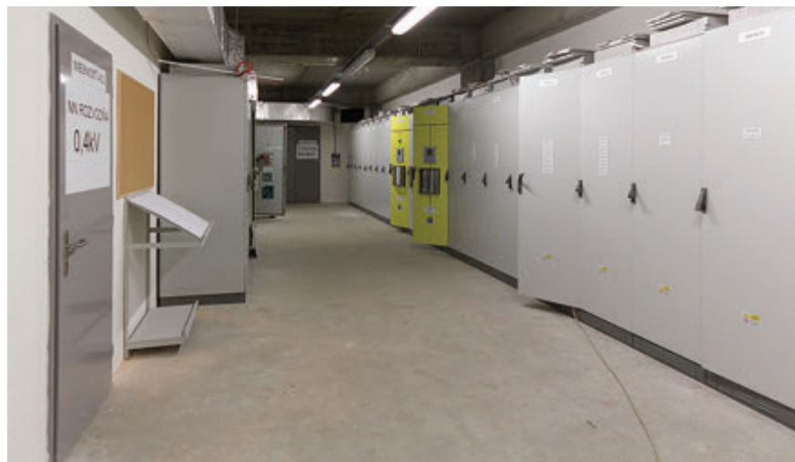
Nová NN rozvodňa 0,4 kV počas montáže
