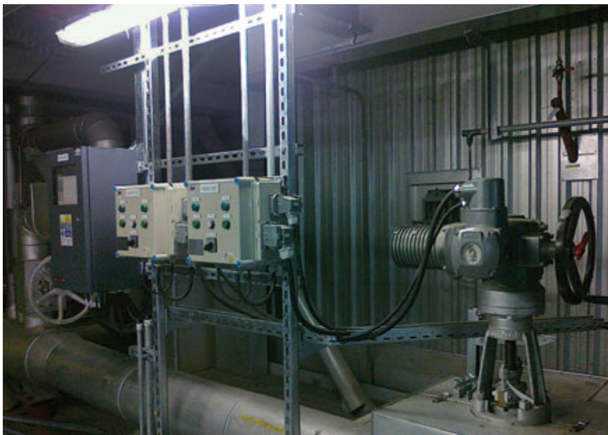
Miestne ovládacie skrinky ventilov s pripojením cez konektory
