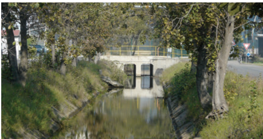
Příklad upraveného koryta s později vestavěným mostem
