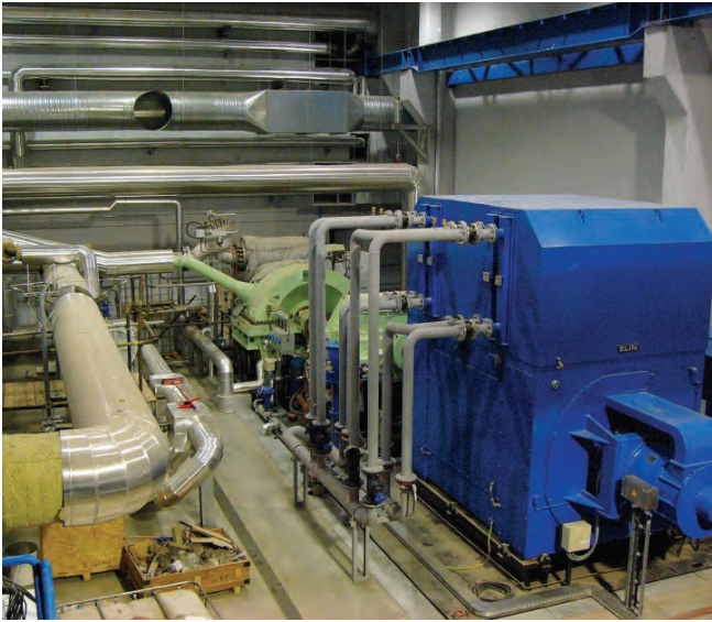
Turbosoustroji bez protihlukového krytu
