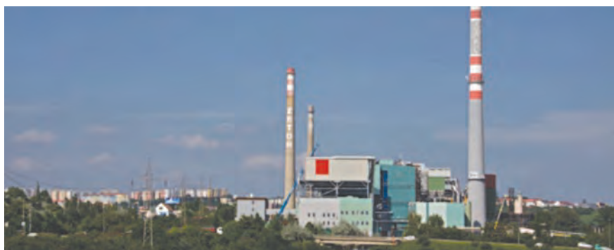
Celkový pohled na SAKO Brno, a.s
