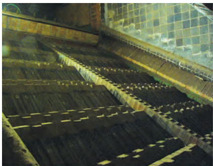
Spalovací rošt s položenými roštnicemi
