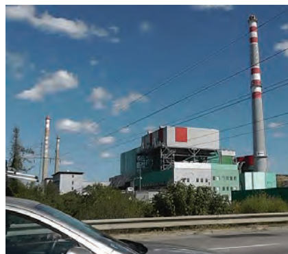
Spalovna je zásadním technologickým zařízením v rámci Jihomoravského kraje a její roční kapacita je cca 230 tisíc tun
