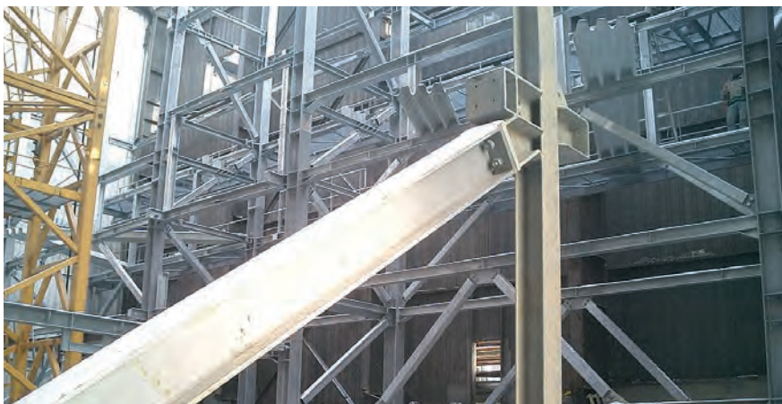
Detail spojení ocelových konstrukcí
