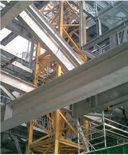
Uvnitř objektu byl postaven montážní věžový jeřáb
