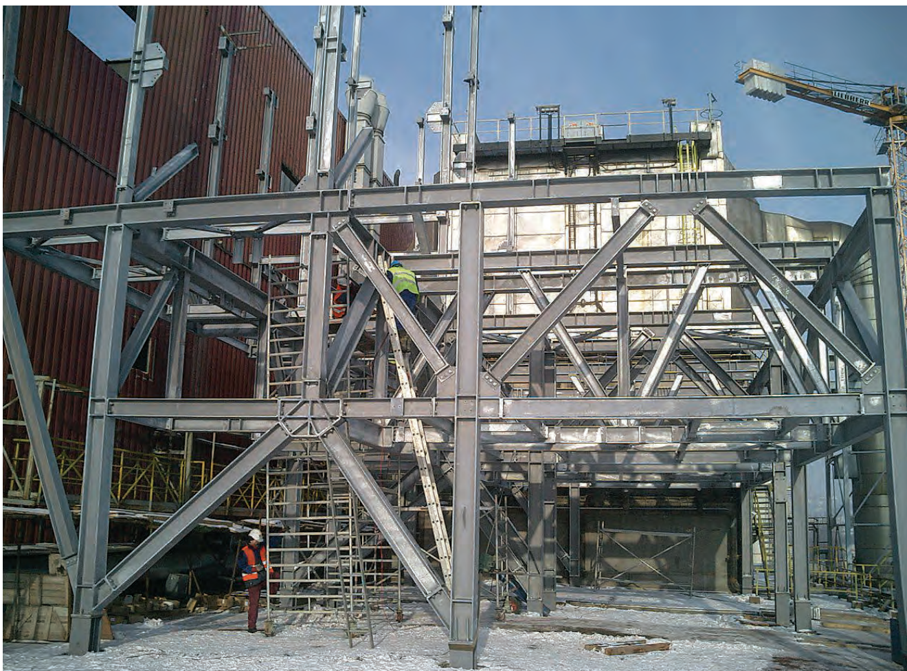
Společnost PSG dodala na stavbu kotelny 530 tun ocelových konstrukcí
