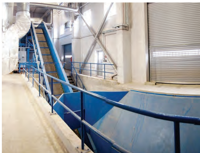
Vstupní násypka a dopravník
