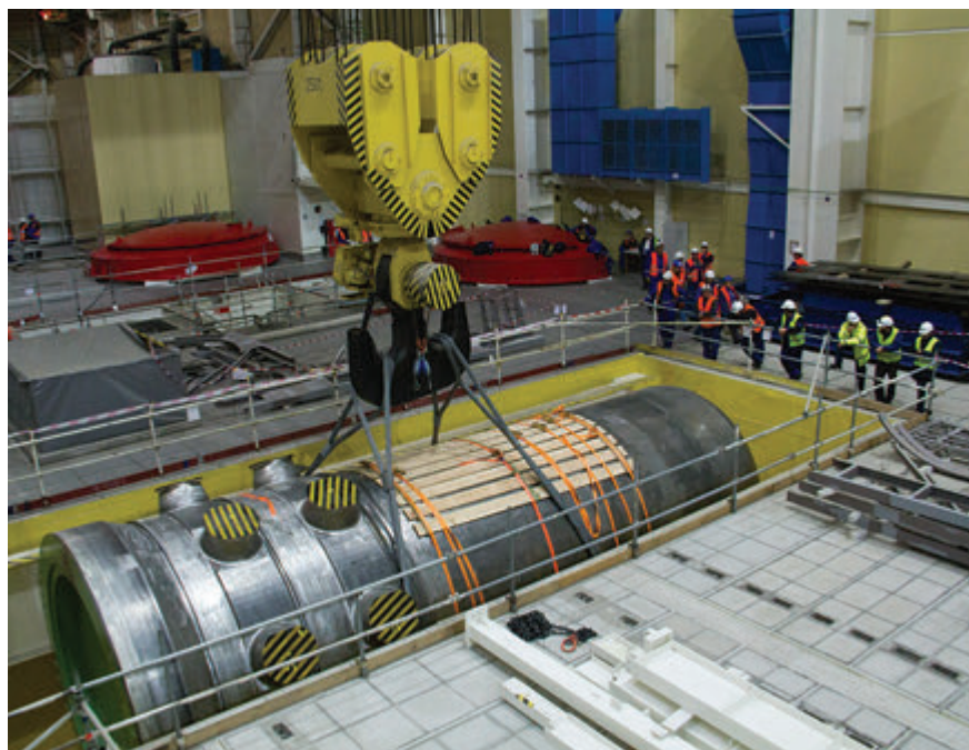
Premiestnenie TNR z koridoru na reaktorovú sálu pomocou mikrozdvihu 250 t zdvihacieho zariadenia - ilustračné foto
