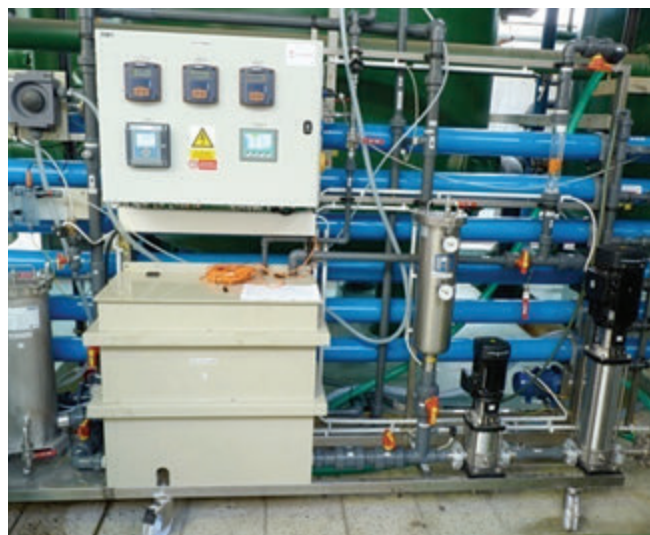
Obr. 1 – Vlevo - pilotní zařízení reverzní osmózy (RO) a elektrodeionizace firmy MemBrain v CHÚV Teplárny Liberec, vpravo - detail RO
