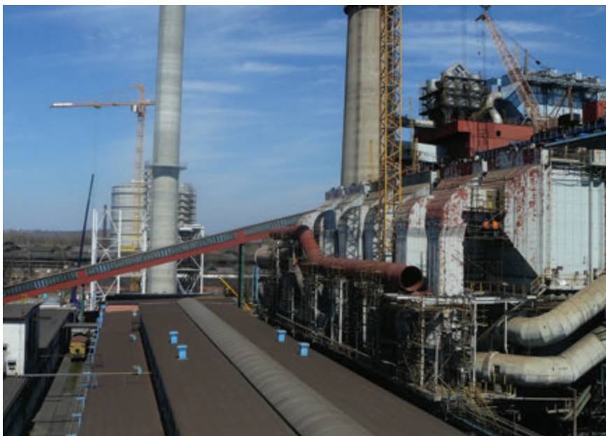
Pohled na elektrické odlučovače prachu. Je vidět i předpřipravený kouřovod do odsíření
