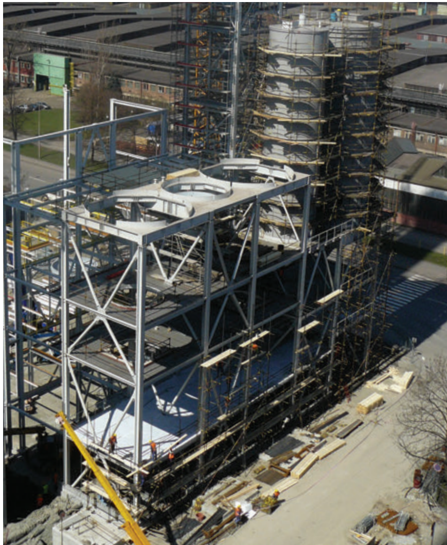
Celkový pohled na staveniště odsíření
