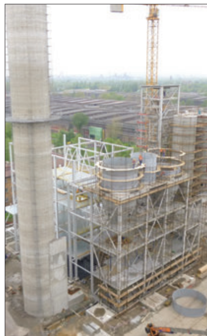
Aktuální stav výstavby odsíření - (květen 2013)
