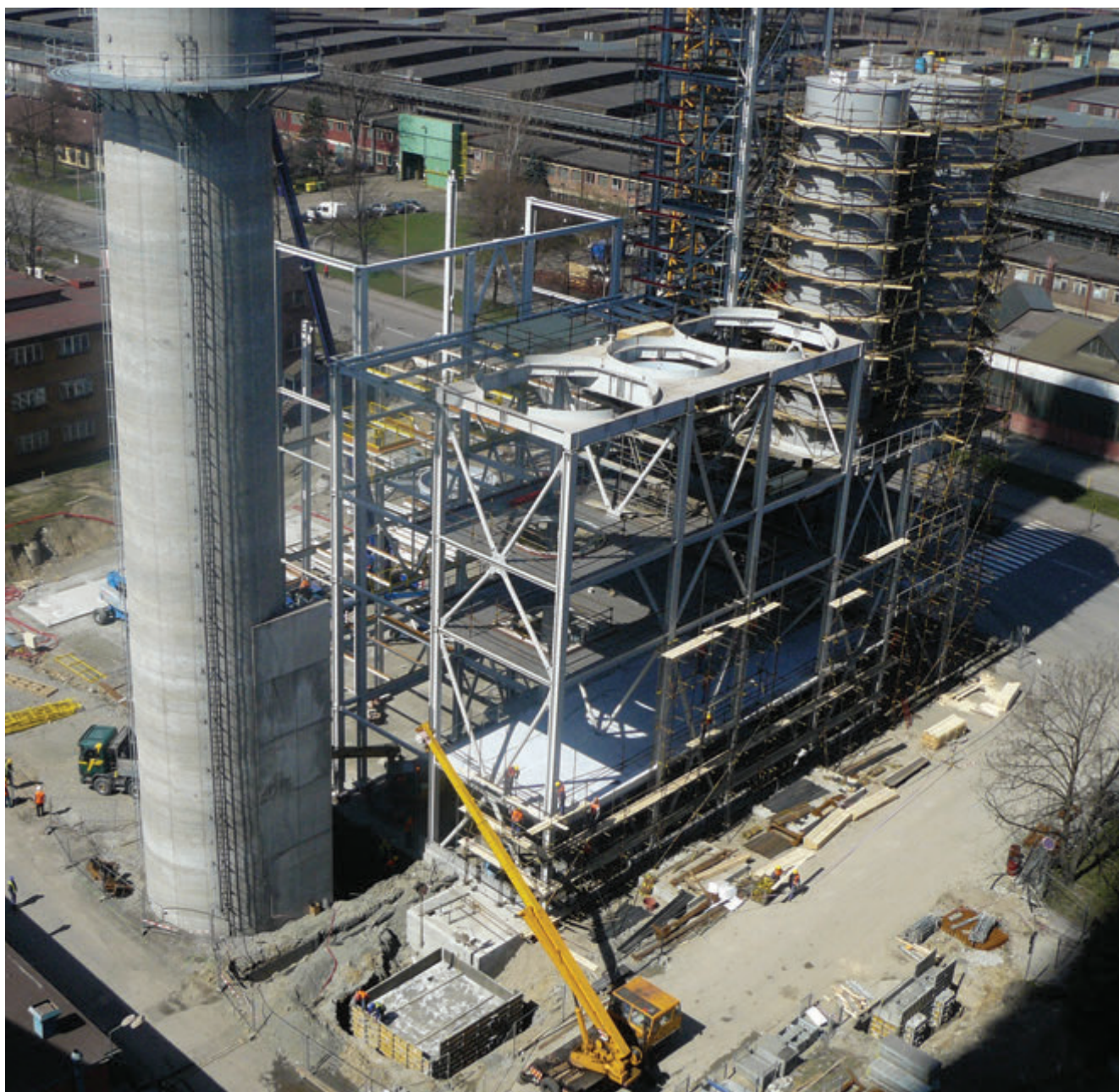
Celkový pohled na výstavbu odsíření
