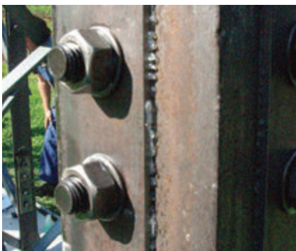
Obr. 8 – Vytlačení tmel na hraně příložky
