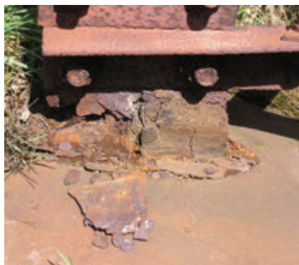
Obr. 4 – Prokorodování nosných prvků v oblasti kotvení stožáru do základů
