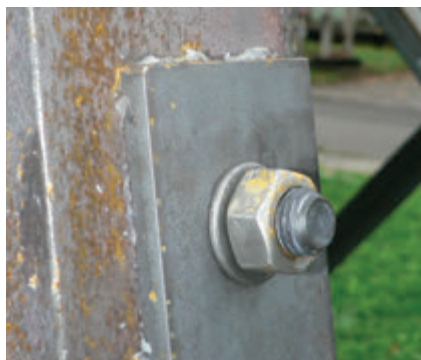
Obr. 8 – Vytlačení tmel na hraně příložky
