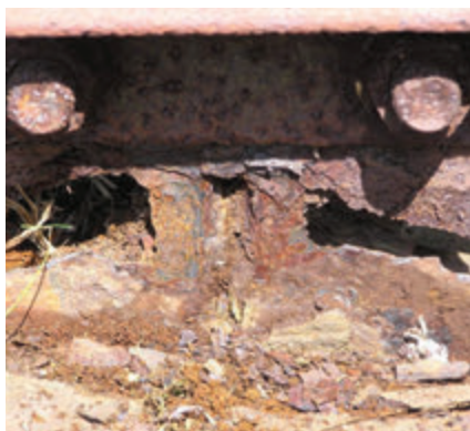
Obr. 4 – Prokorodování nosných prvků v oblasti kotvení stožáru do základů
