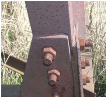
Obr. 5 – Štěrbínová koroze ve šroubovaném spoji nárožníků
