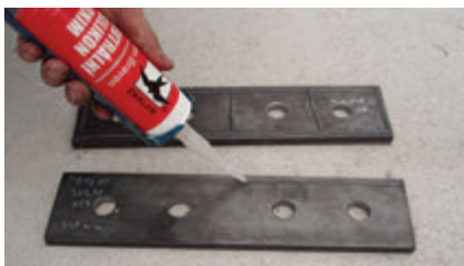
Obr. 7 – Nanášení tmelu na příložky
