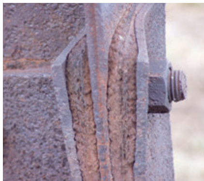
Obr. 5 – Štěrbínová koroze ve šroubovaném spoji nárožníků
