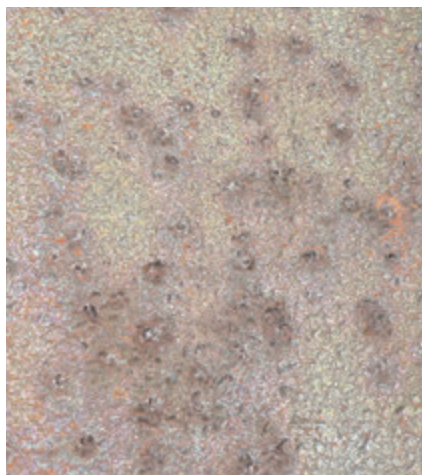
Obr. 3 – Typický vzhled patiny na nárožních stožáru
