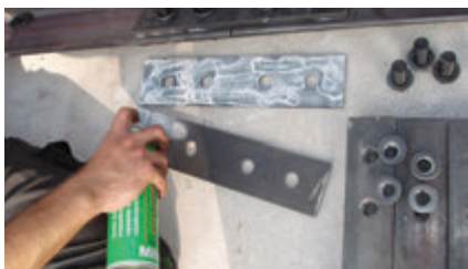
Obr. 9 – Nanášení teflonové vazelíny na příložky
