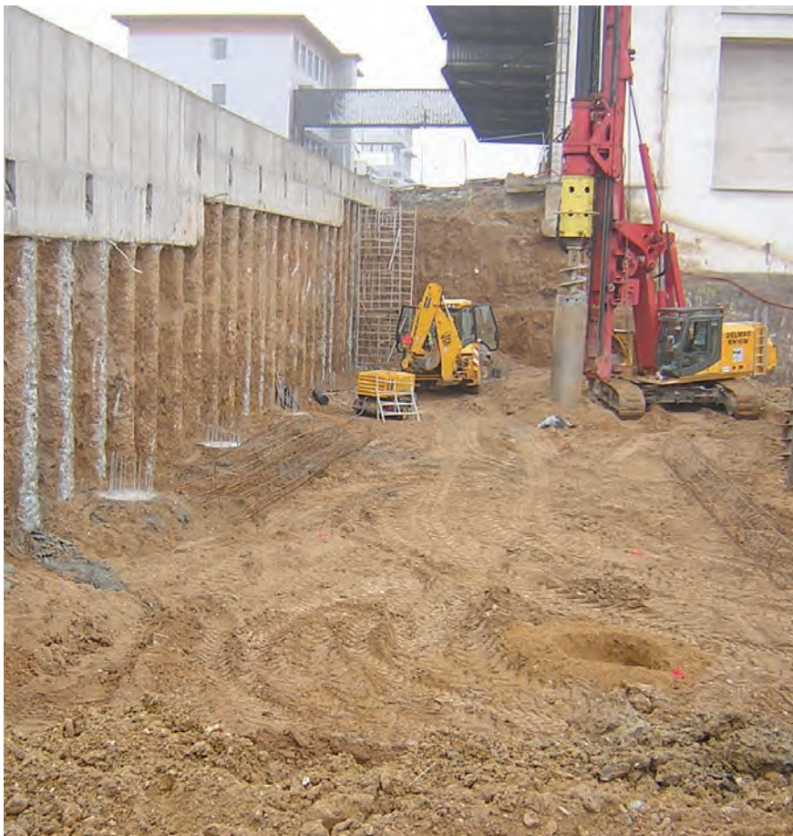
Pohled na pilotovou stěnu
