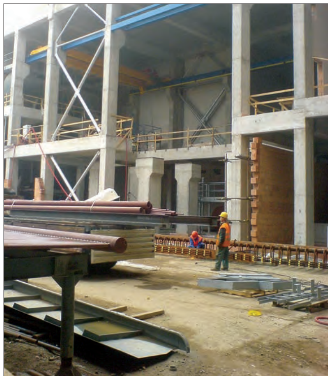
Uzpůsobení železobetonové konstrukce pro montáž turbíny
