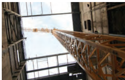
Pohled na demontovanou střechu
