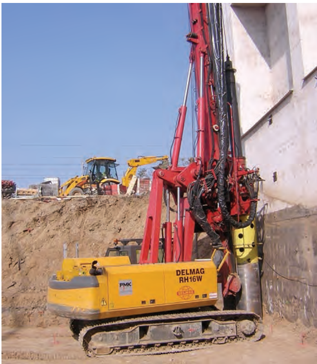
Provádění pilot nové haly navazující na stávající halu
