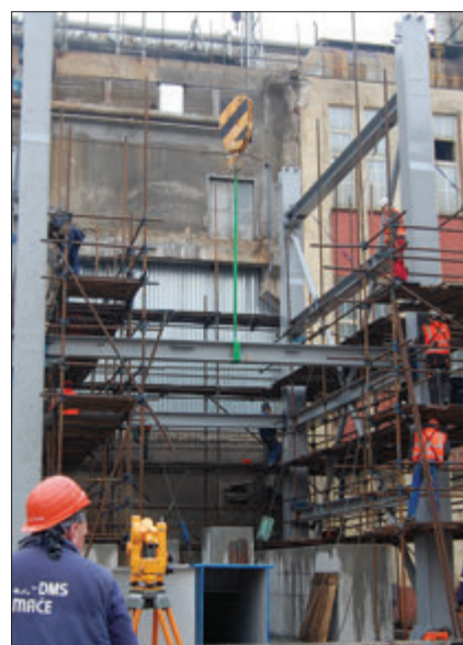
Montáž ocelevej konštrukcie
