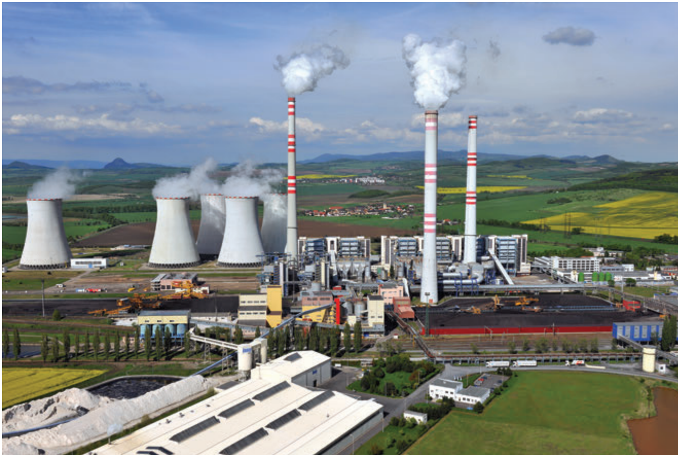
Celkový pohled na elektrárnu - ilustrační foto
