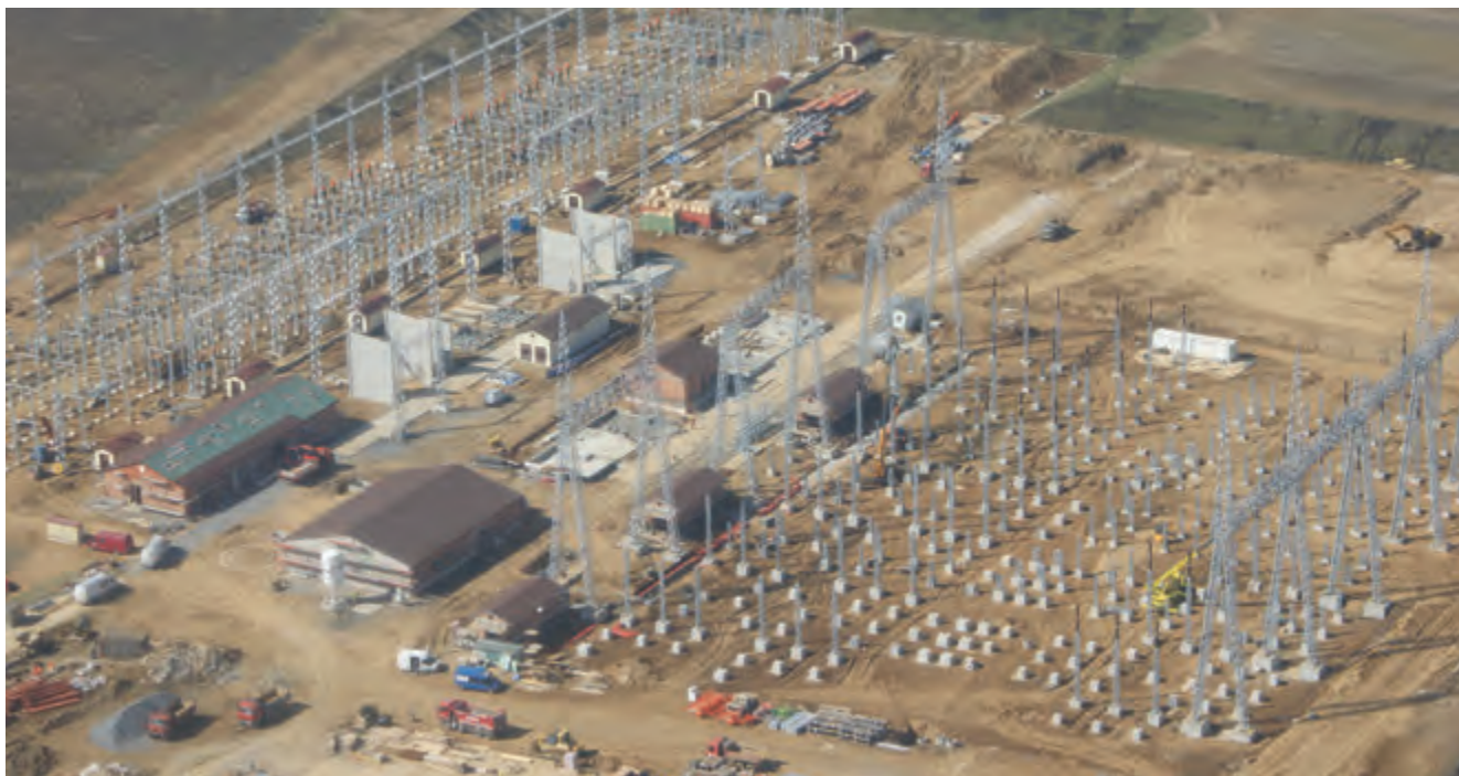
Pro povrchovou ochranu byl vybrán dvourvrstvý rozpouštědlový nátěrový systém Jotun
