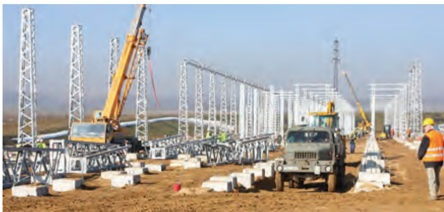
Příhradové ocelové konstrukce na stavbě rozvodny Kletné
