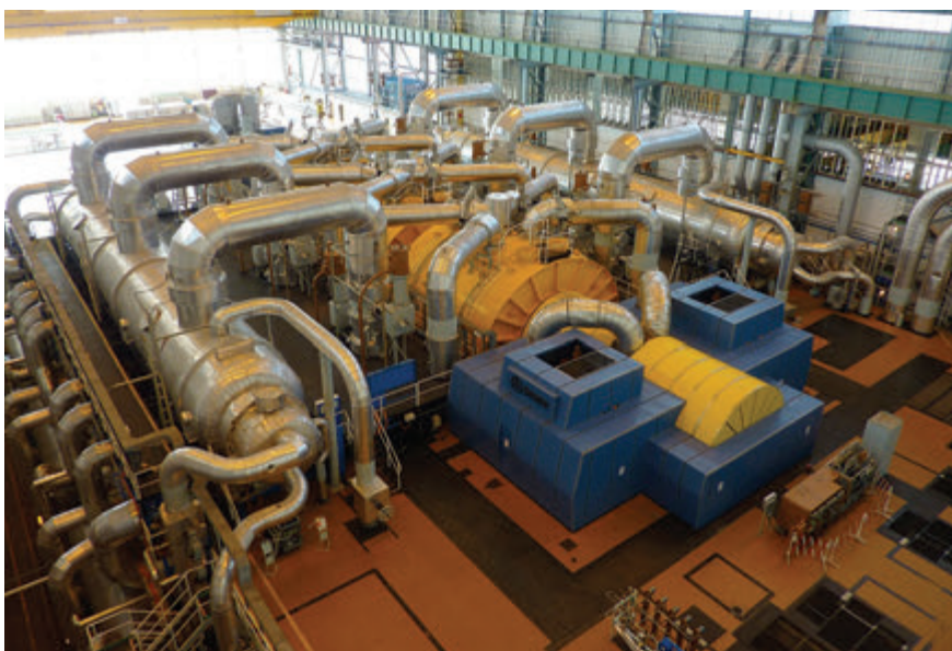
Obr. 5 – Celkový pohled na turbosoustrojí bloku 1 JE Temelín (Pozn. v pravém dolním rohu je vysokotlaký díl - žlutomodrý kryt, za ním na společné hřídeli tři nízkotlaké díly, u kterých dojde v roce 2014 k záměně)
