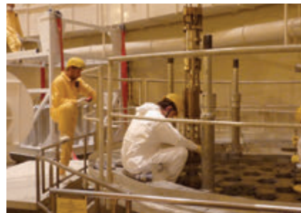
Obr. 1 – LKP, nové bloky elektromagnetů a montáž bloků elektromagnetů do horního bloku reaktoru
