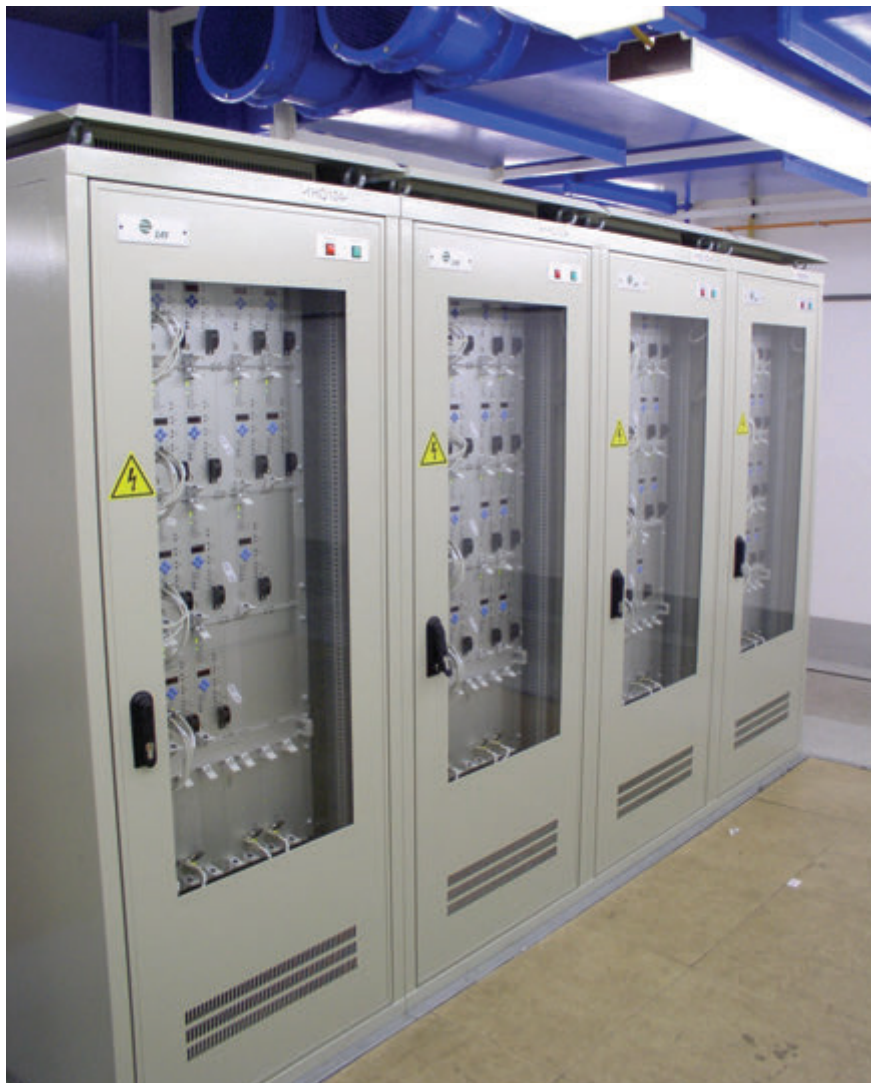
Obr. 2 – Nová skříň systému měření polohy regulačních orgánů
