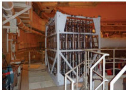
Obr. 1 – LKP, nové bloky elektromagnetů a montáž bloků elektromagnetů do horního bloku reaktoru
