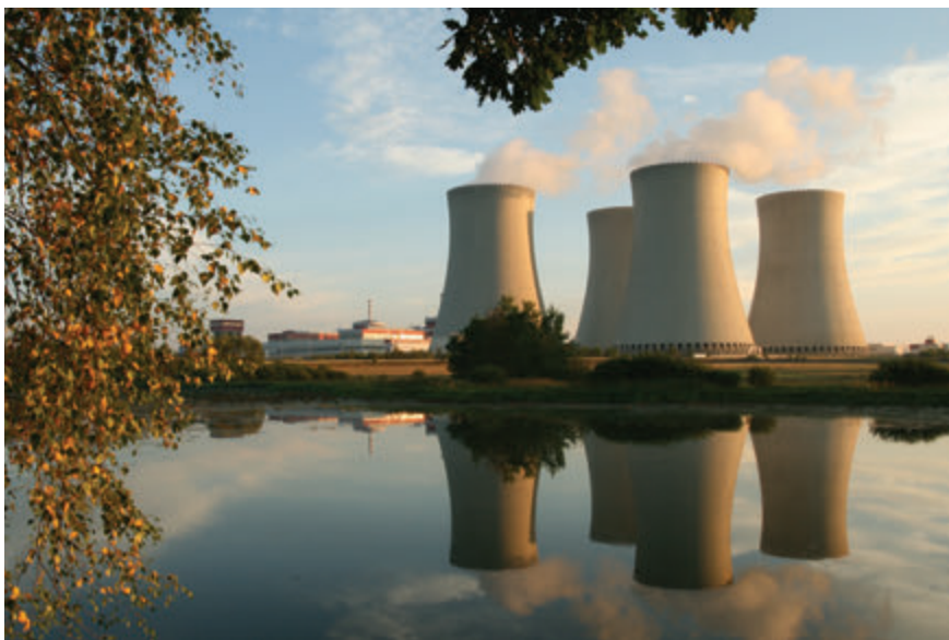
Chladičové věže jaderné elektrárny Temelín
