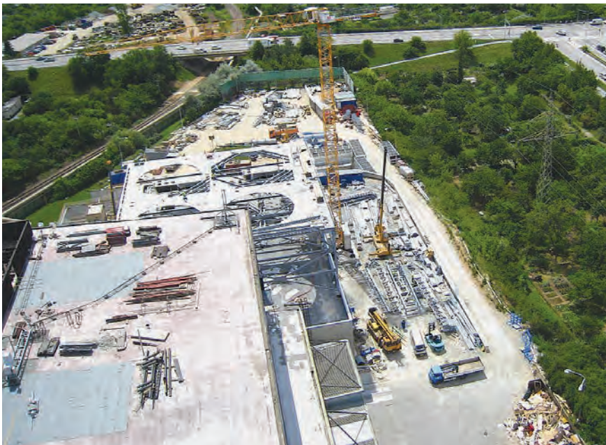
Letecký pohled na staveniště
