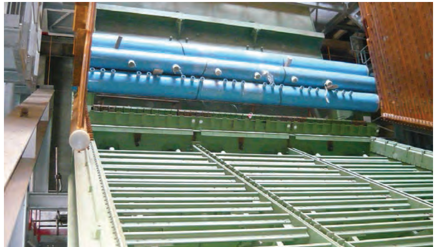
Montáž roštu kotle
