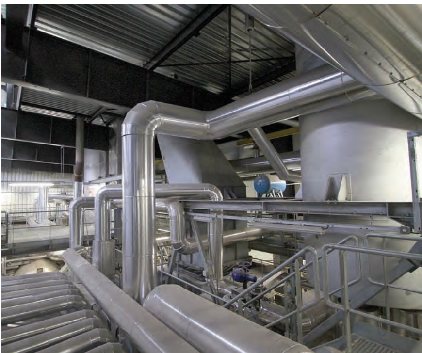
Pohled na strop kotelny
