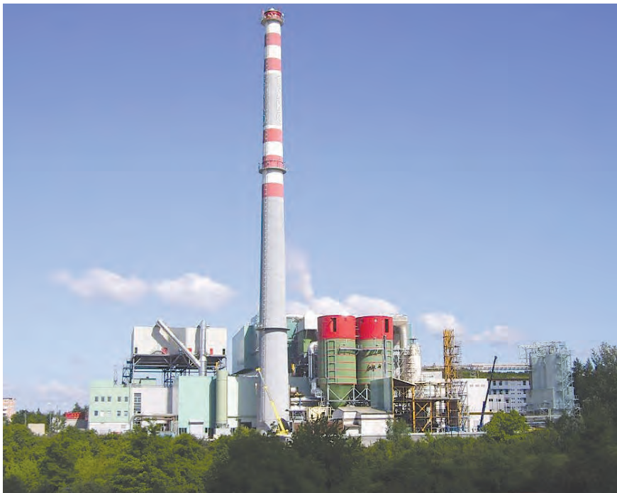
Celkový pohled na spalovnu
