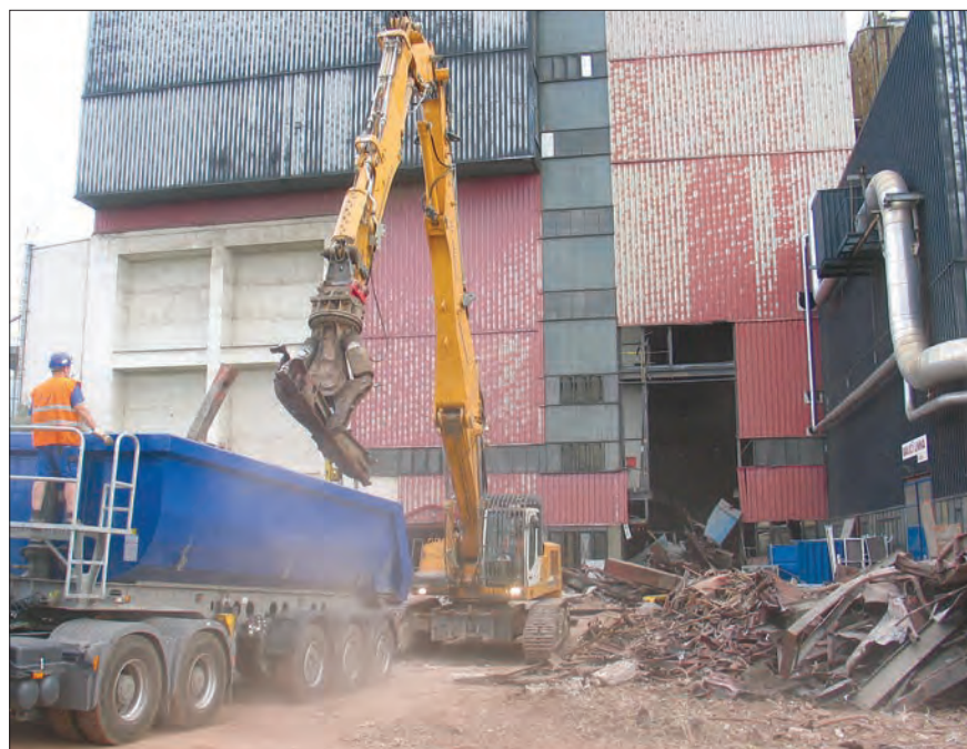
Demolice starých částí spalovny
