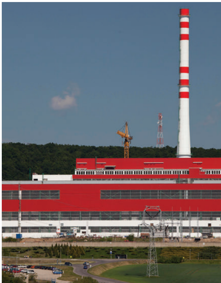
Pohľad na strojovňu 3. a 4. bloku - ilustračné foto
