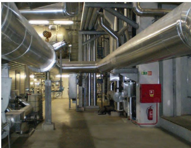
Obr. 5 - Vstupný parovod turbíny
