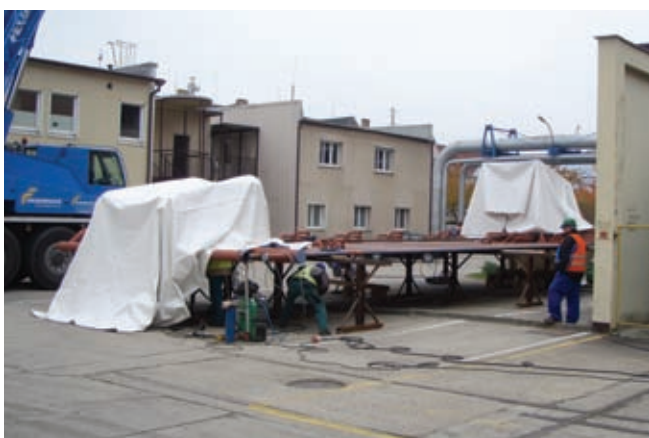
Stany na svařovacích pracovištích - ochrana před povětrnostními vlivy při svařování v ochranné atmosféře
