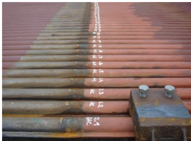
Linie svarů membránových stěn svařovaných na předmontážní plošině
