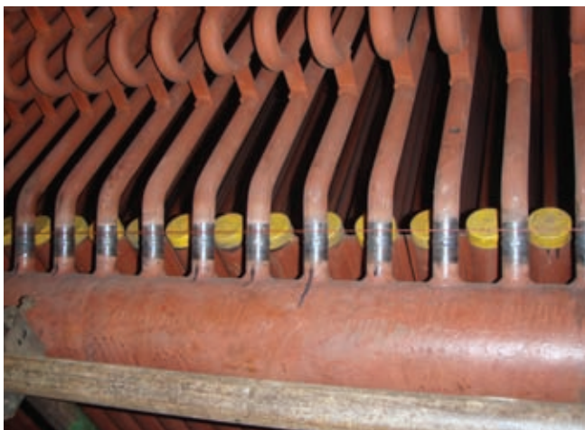
Montážní svary na přehříváku P1, II. tah kotle
