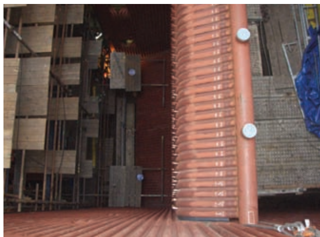
Ustavení membránové mezistěny, pohled do II. tahu kotle
