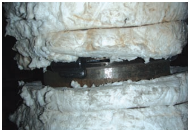
Montážní spoj - hrdlo kotlového tělesa + zavodňovací potrubí
