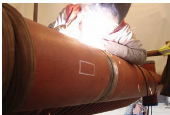
Svařování komory obalovanou elektrodou (ESAB)
