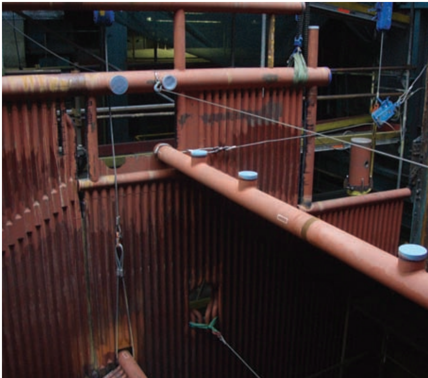
Ustavení membránových stěn na montážní pozici zdvihacími zařízeními
