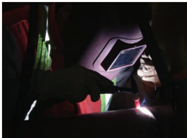
Svařování kořenové vrstvy komory DN 200 (ESAB)
