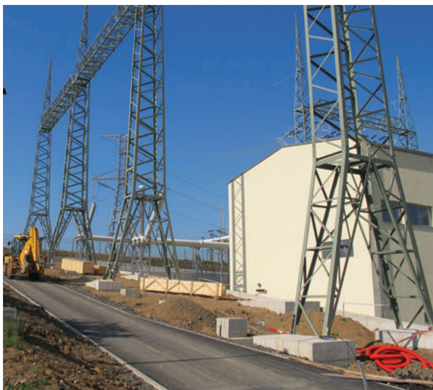
Výškový rozdíl na stavebním pozemku činí 12 metrů
