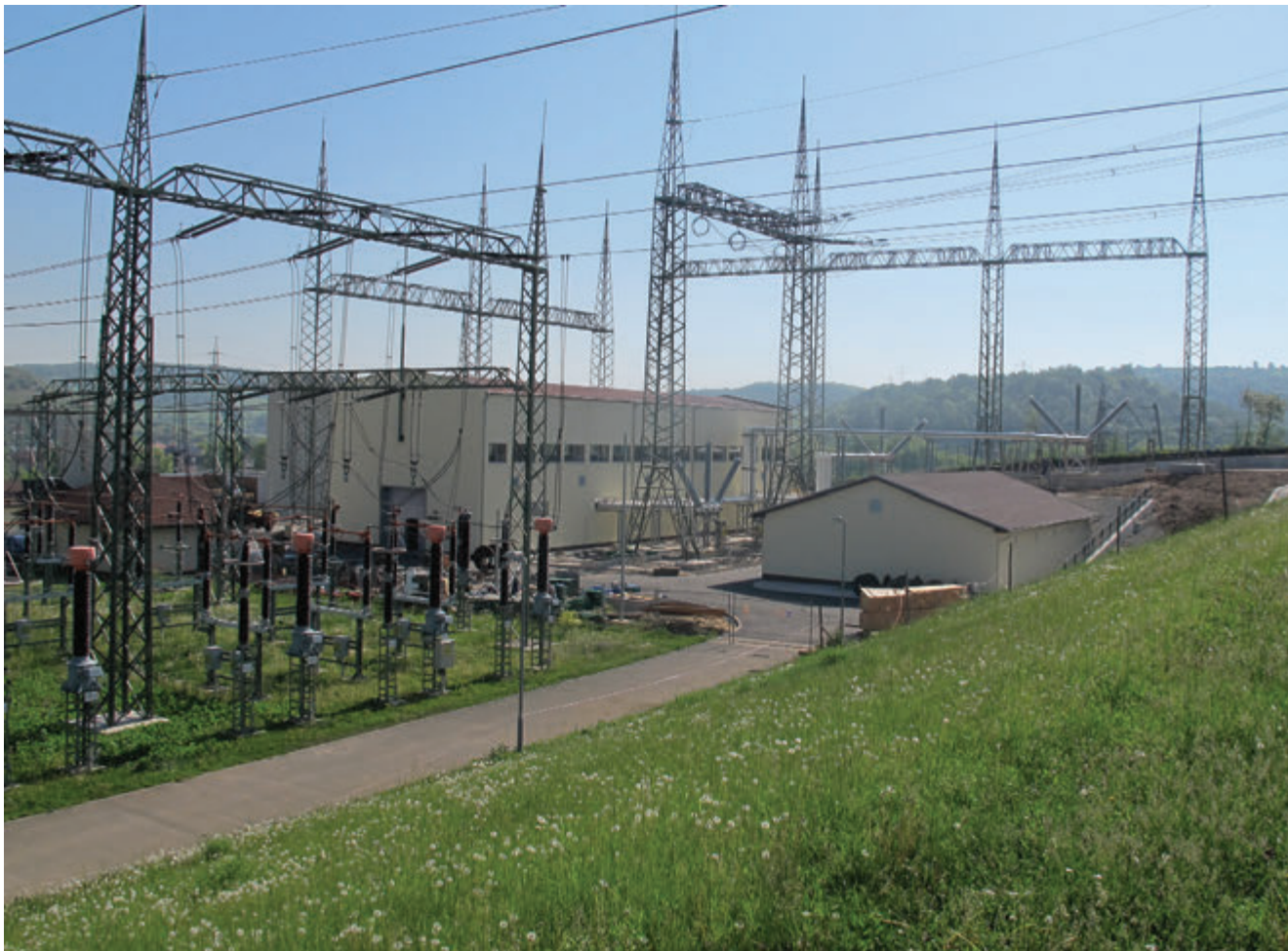
Celkový pohled na objekty nové rozvodny
