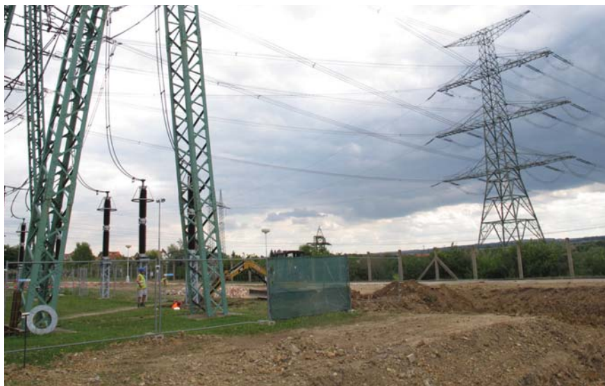
V době naší návštěvy (srpen 2012) se naplno rozběhly stavební práce
