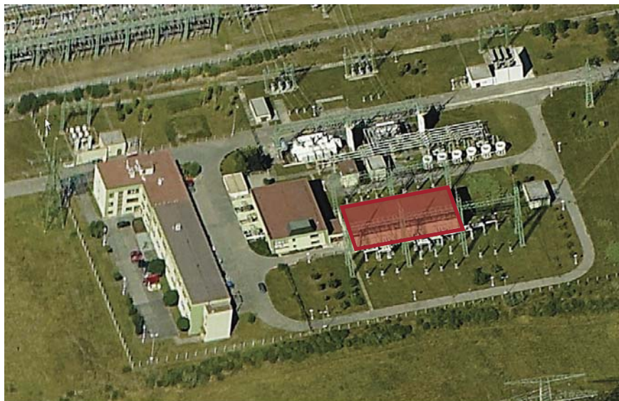
Obr. 1 – Umístění zapouzdřené rozvodny 420 kV Chodov
