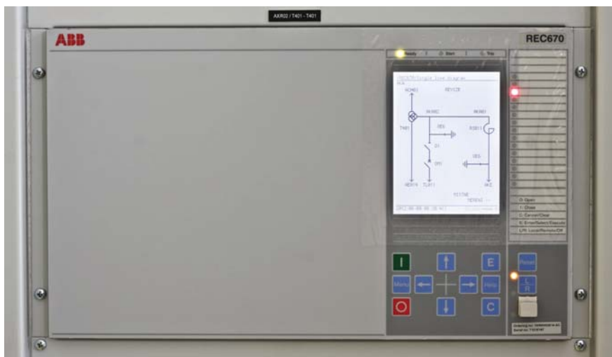
IED pro sběr dat a ovládní vývodu REC670
