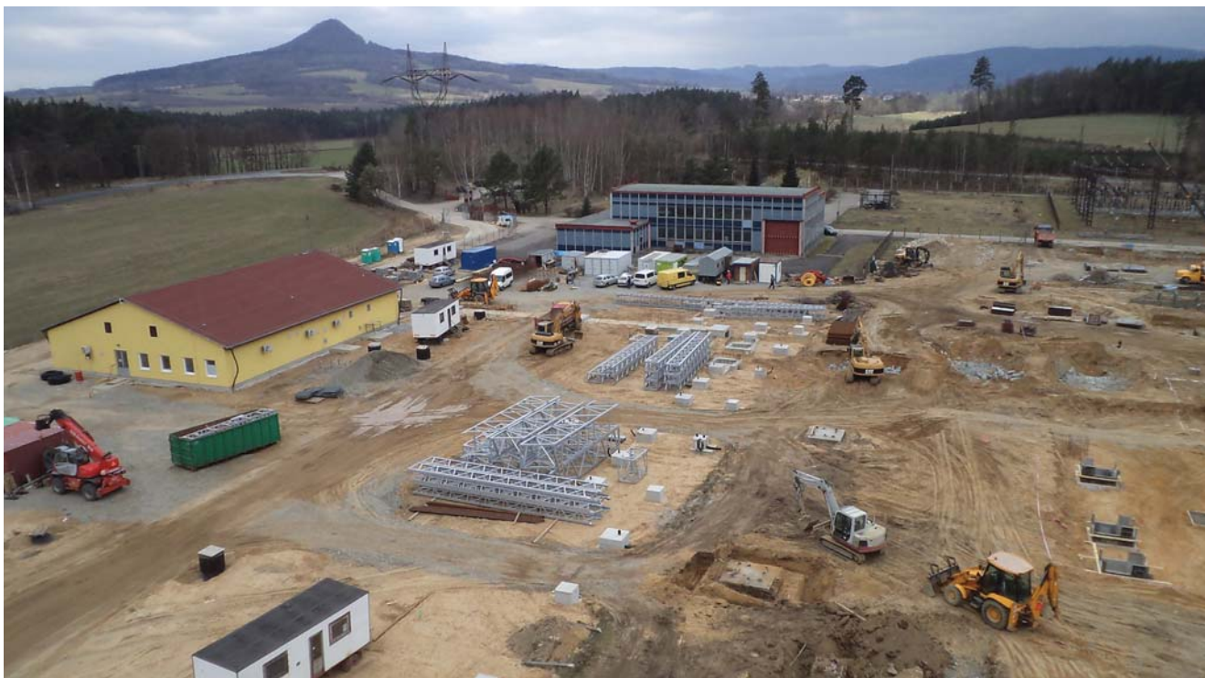
Staveniště lokality Babylon
