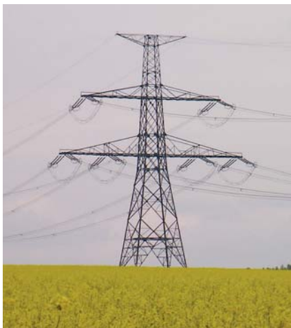
Příklad kotevního stožáru typu Donau, dvojité vedení - ilustrační foto
