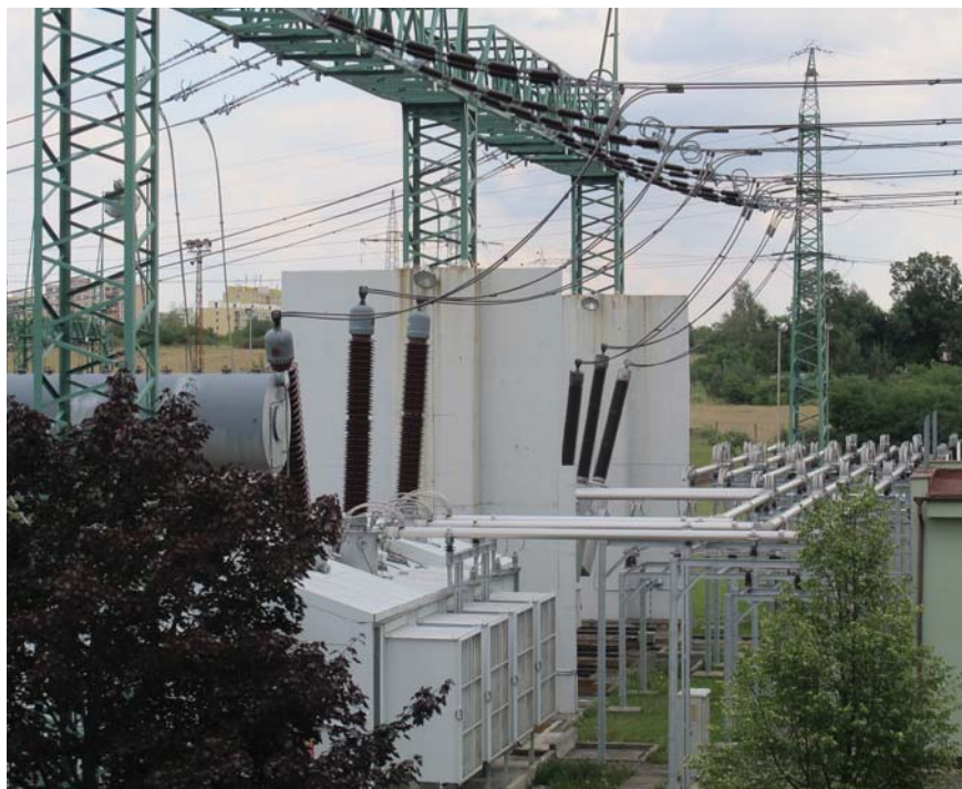
Instalace nového transformátoru v Chodově bude stát 400 milionů korun
