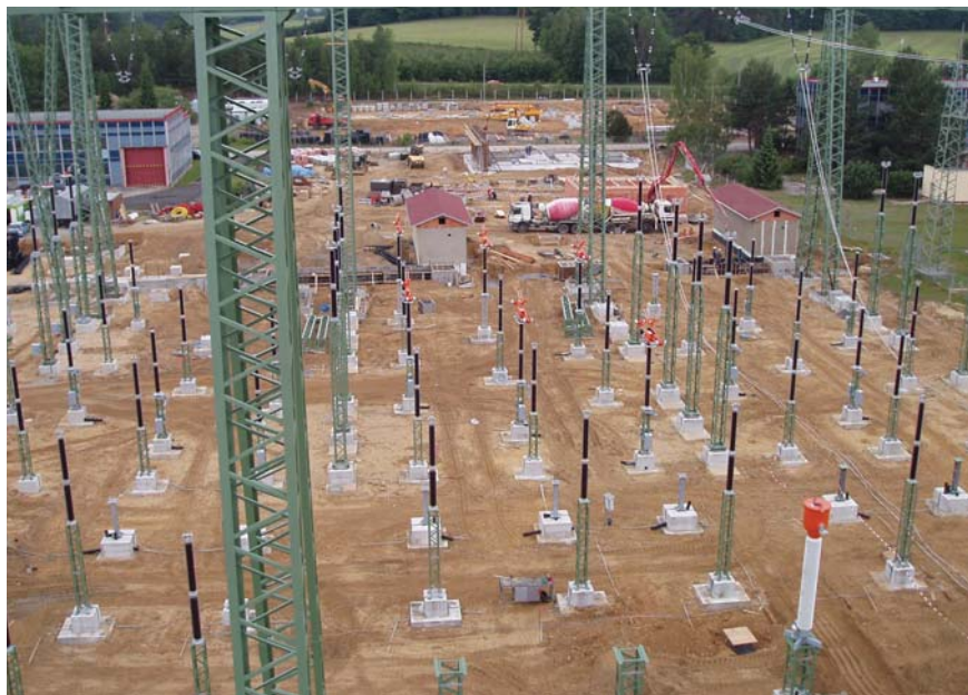
Celkový pohled na probíhající modernizaci trafostanice Babylon
