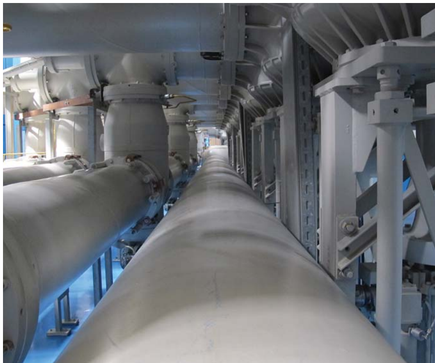
Detail rozvodu zapouzdřené rozvodny
