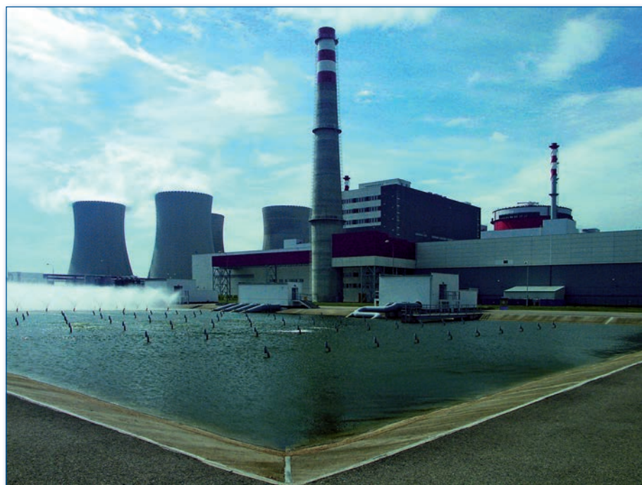
Jaderná elektrárna Temelín
