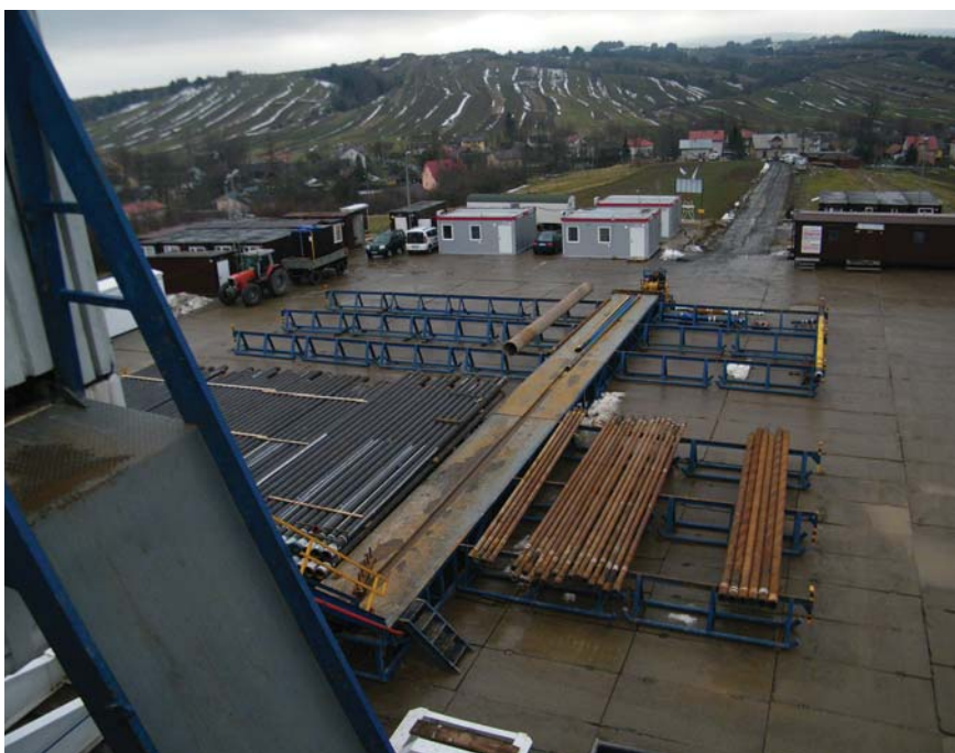
Pohled na vrtné pracoviště
