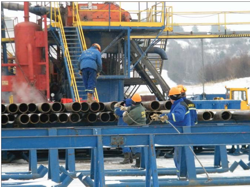
Ocelové trubky (pažnice) před zapuštěním do vrtu ukazují, jak malý je průměr vrtu
