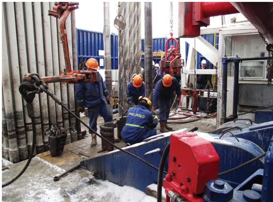
Práce na vrtné soupravě. Hluboký vrt v Polsku
